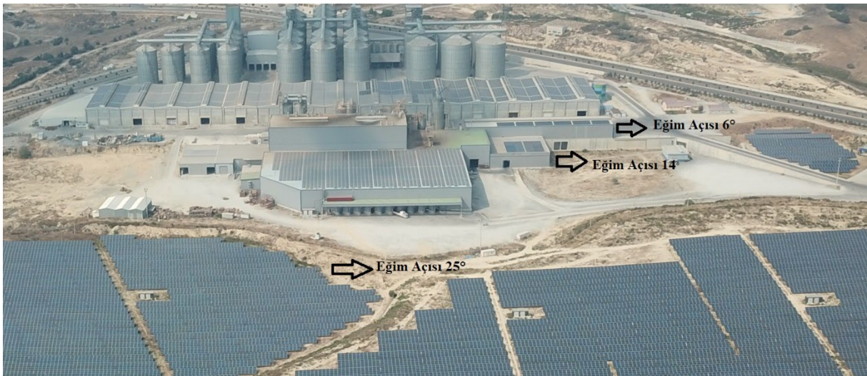
Şekil 4.16. Çatı ve arazi modül eğim açıları.
