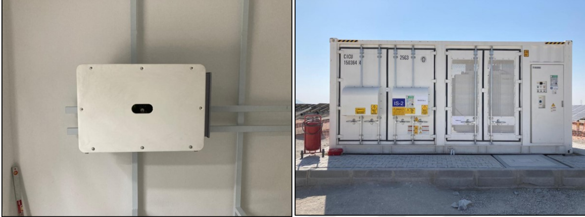
Şekil 3.13. İki farklı evirici (inverter)
