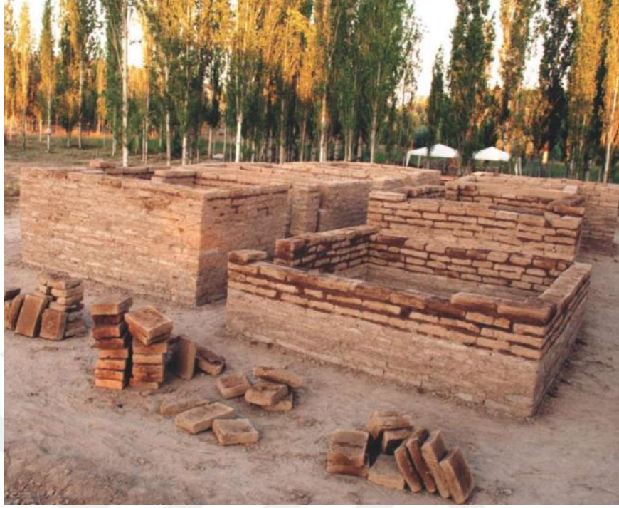
Levha 24. 1: Aşıklı Höyük deneysel dörtgen planlı kerpiç yapıların inşa aşaması (Özbaşaran vd., 2010: 227 res:11)
