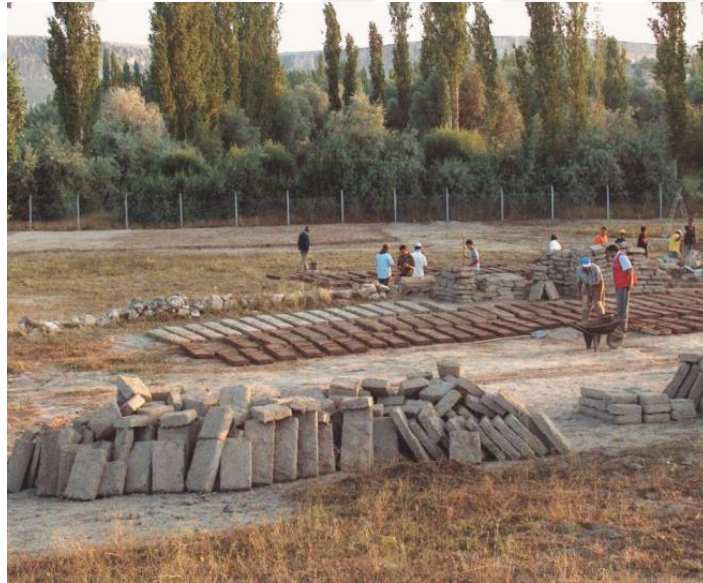
Levha 23. 2: Aşıklı Höyük kerpiç tuğlalarının üretimi ve güneşte kurutulması
