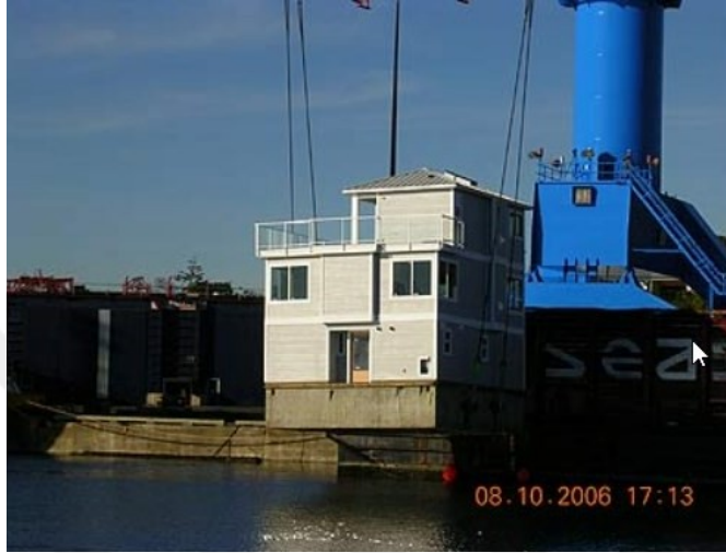
Şekil 3.16: Karada üretilen bir yüzer yapı suya indiriliyor (Url-8).
