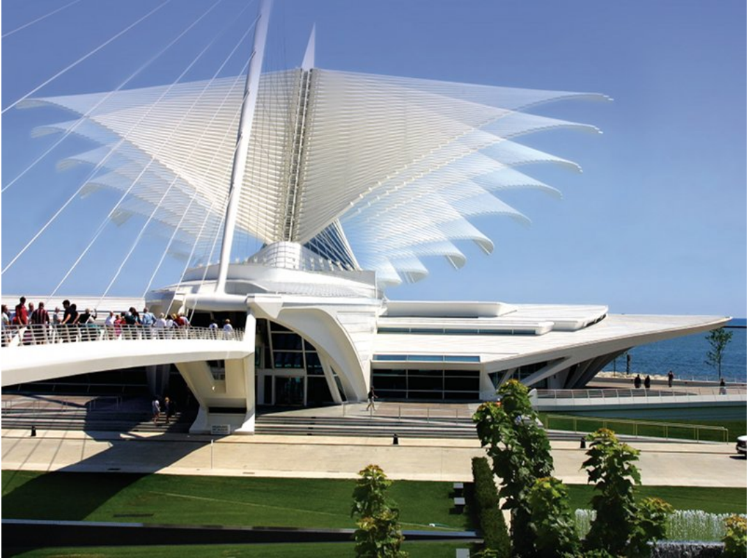
Şekil 4.19: Milwaukee Sanat Müzesi'nin kanatlarının açılıp kapanma hareketi, Santiago Calatrava, 1994 (Ekmekçi, 2005).
