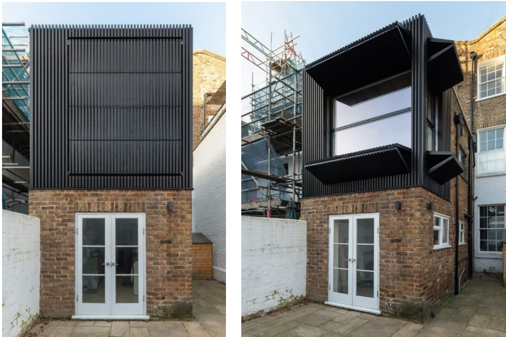
Şekil 4.12: Kara Kutu Apartmanı’nın kapalı durumda kinetik cephesi (solda), açık konumda kinetik cephesi (sağda) (Griffiths, 2019).
