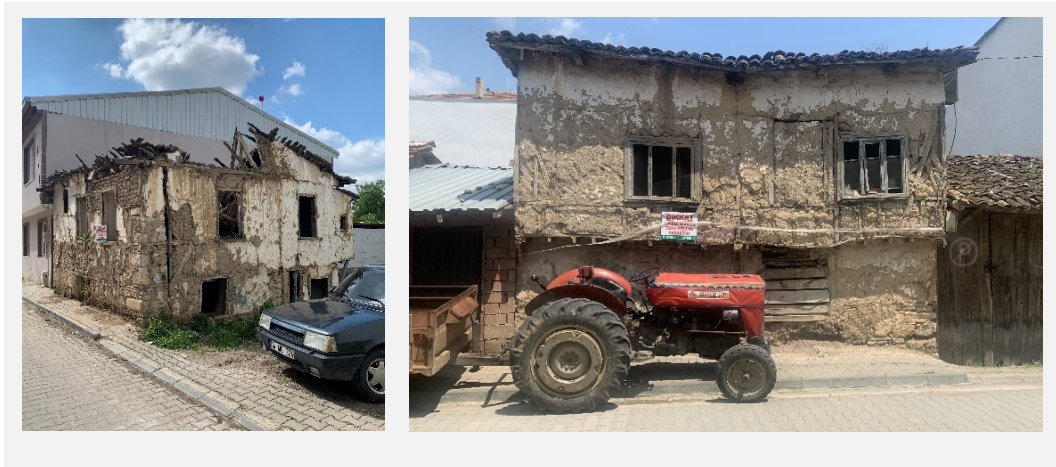
Şekil 4.32 Sivil mimarlık örnekleri ve strüktürel bozulmalar (Yavuz, 2023.)
