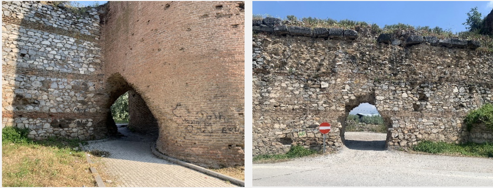
Şekil 4.33 Kent Surları ve niteliksiz müdahaleler (Yavuz, 2023.)
