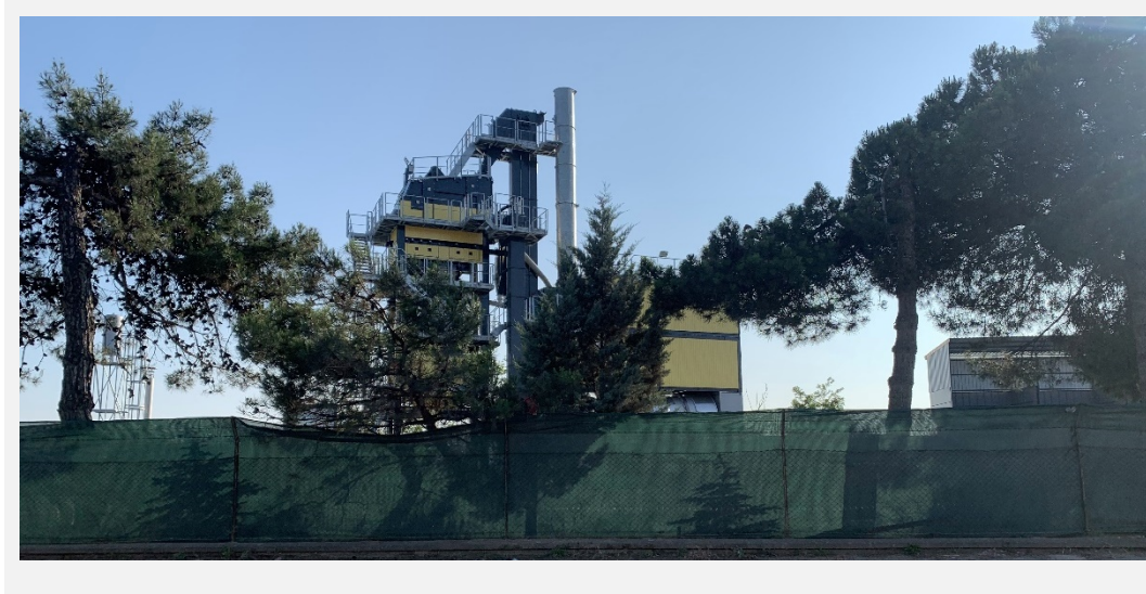
Şekil 4.19 Göl kıyısında yer alan asfalt üretim tesisi (Yavuz, 2023.)
