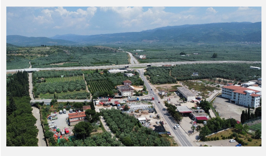
Şekil 4.37 İznik'in doğusundaki otoyol inşaatı (Yavuz, 2023.)
