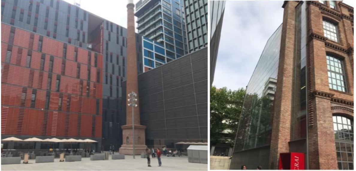
Şekil 8:Pompeu Fabra Üniversitesi Dışı Mekan Görsele 2
