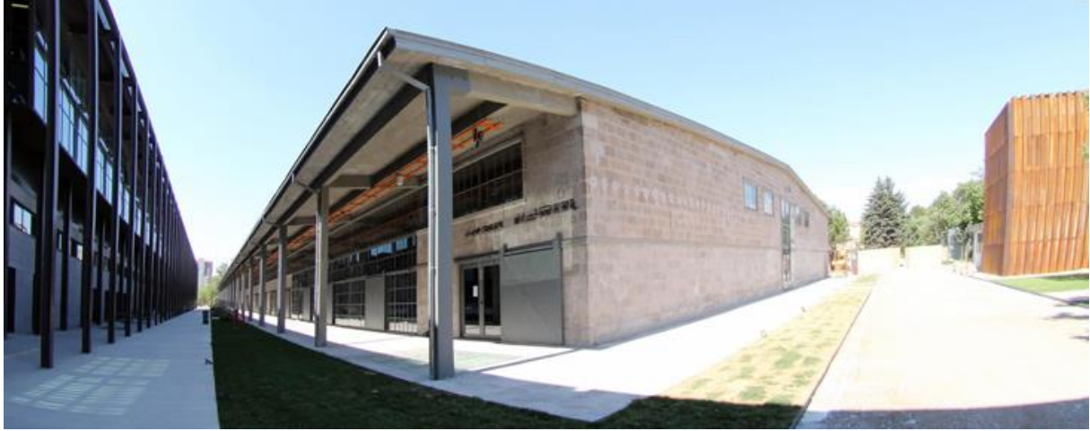
Şekil 65:İtfaiye bina yapısı dış cephe görünümü
