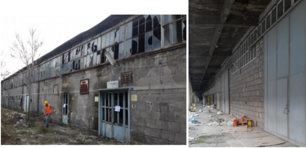
Şekil 67: Ana ambar binası eski görselleri
