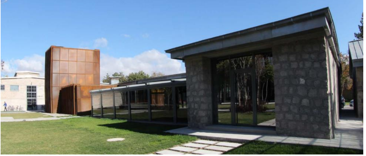
Şekil 76:Agü Sümerbank İtfaiye Binası Dış Cephe Görşeli
