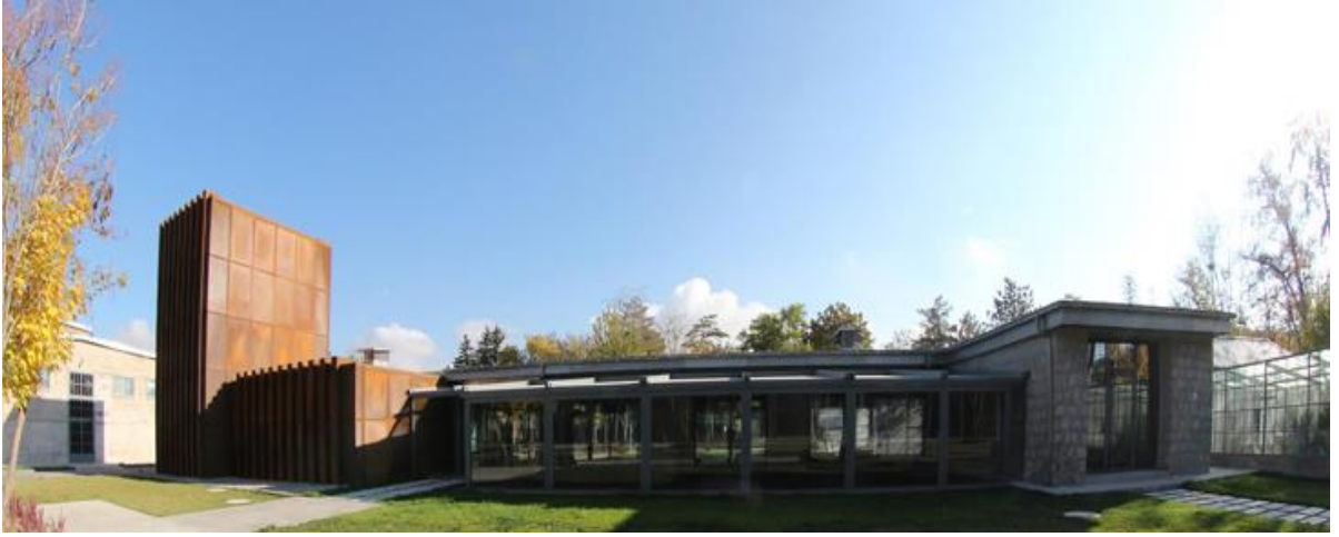
Şekil 77:Agü Sümerbank İtfaiye Binası Dış Cephe Görşeli -1
