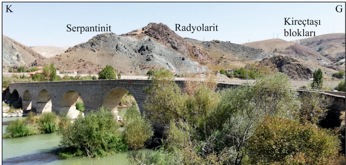
Şekil 4.4 Kalecik yolu üstü Kızılırmak Köprüsü çevresinde Radyolarit, Serpantinit ve Kireçtaşı bloklarını içeren genel görünüm, doğuya bakış
