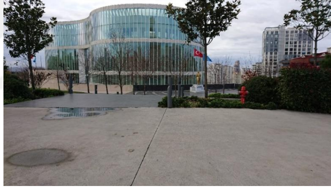
Şekil 4.96 : Yapı alanında bulunan hydrant.
