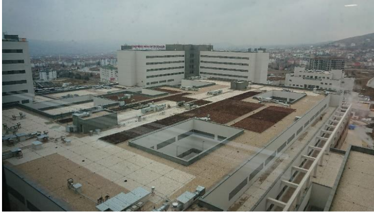
Şekil 4.24 : Yeşil çatı uygulaması.
