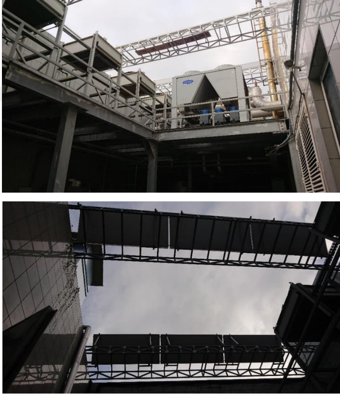
Şekil 4.101 : Güneş panelleri yerleşimi.
