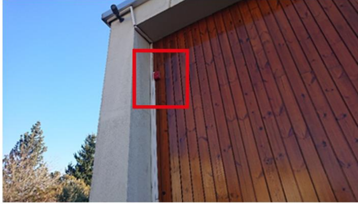
Şekil 4.44 : Bina cephesinde sesli ve ışıklı ikaz cihazı.
