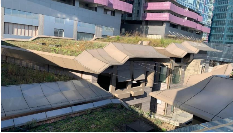
Şekil 4.109 : Sitede yer alan yeşil çatı uygulamaları.
