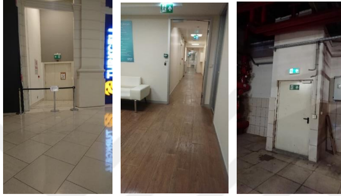
Şekil 4.3 : AVM içinde, yönetim biriminde ve teknik hacimlerde acil durum çıkış kapıları ve acil durum yönlendirme üniteleri.
