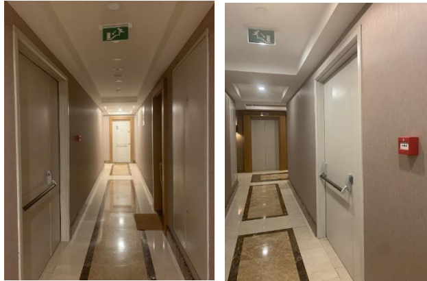
Şekil 4.106 : Acil durum yönlendirmeleri ve yangın kapıları.
