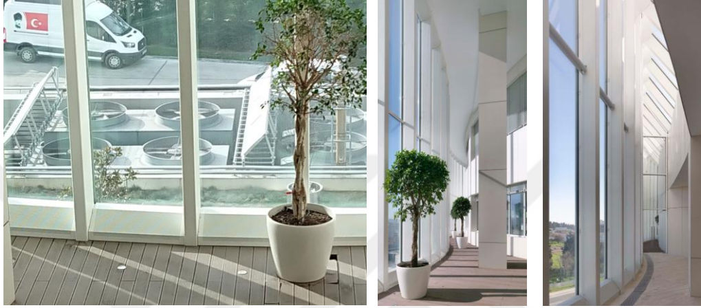
Şekil 4.99 : Giydirme cephe döşeme birleşimi ve bölücüleri.
