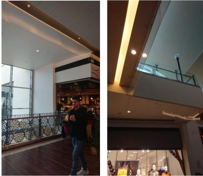
Şekil 4.60 : Duman bariyerlerinin bulunduğu bölümler.
