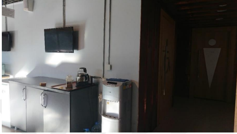
Şekil 4.46 : Binada yer alan sıva üstü kablo tesisatı.
