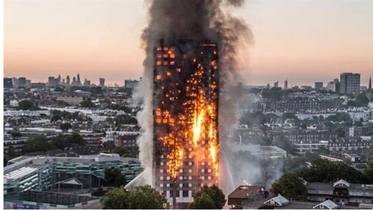
Şekil 3.2 : Grenfel Tower yangını (Url-16).
