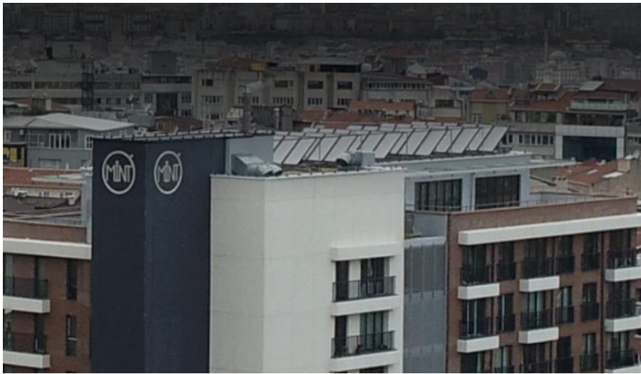
Şekil 4.149 : Binada bulunan güneş paneli yerleşimi (Url-13).
