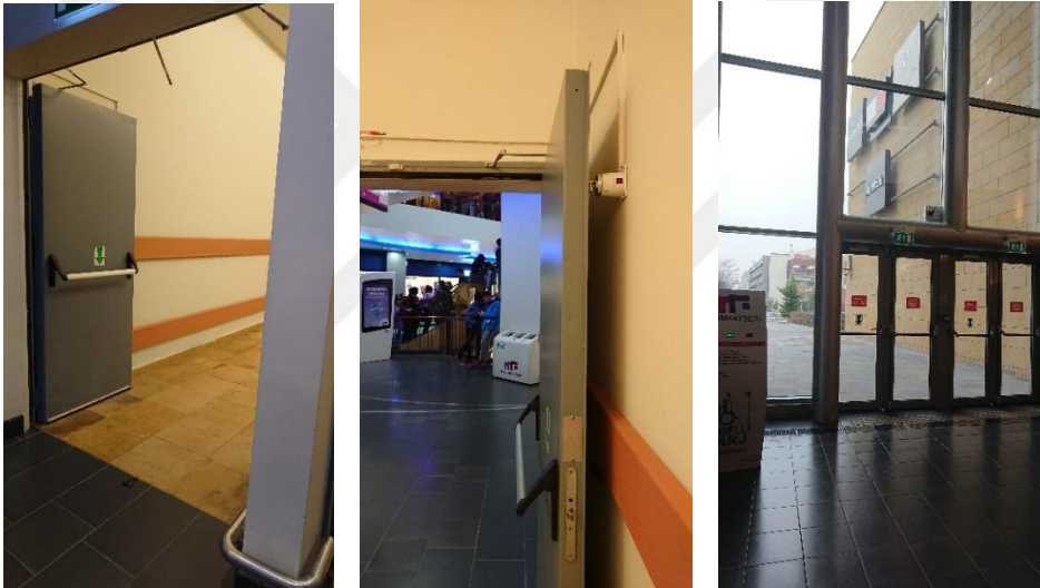
Şekil 4.62 : Binada kullanılan yangın kapıları.
