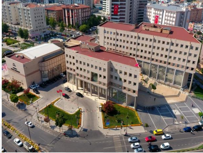
Şekil 4.32 : Gaziantep Büyükşehir Belediyesi Hizmet Binası.
