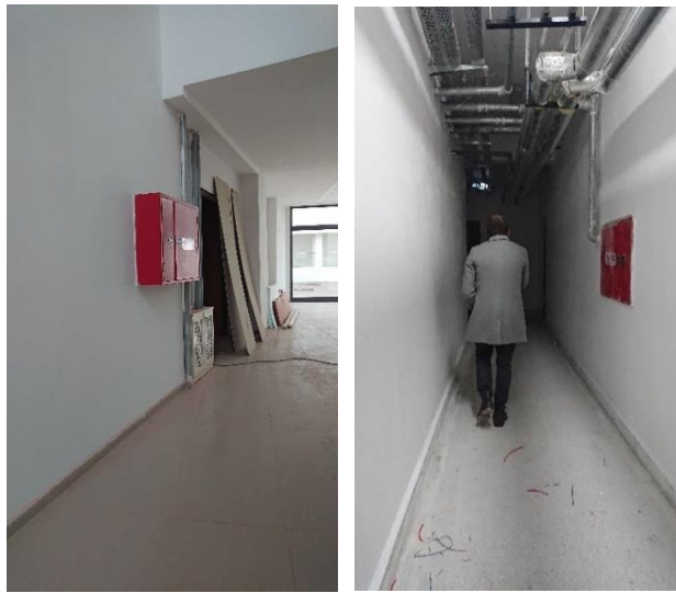
Şekil 4.115 : Bina içinde yangın dolaplarının yerleşimi.
