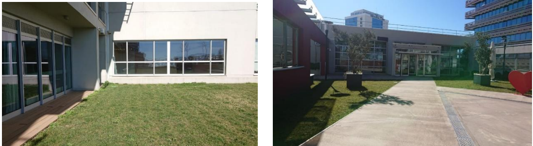
Şekil 4.86 : Yeşil çatı uygulaması.
