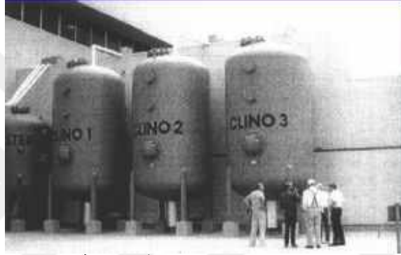
الشكل رقم (30): يبين استخدام الزيوليت في معالجة المياه المختلفة Zeolite-water-purification tanks-Zeolite filled water tanks-Denver, CO Mumpton 1999
