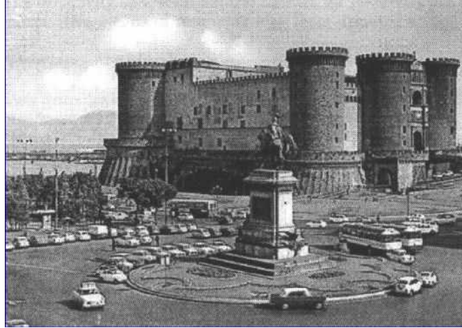
الشكل رقم (31): يبين استخدام طف الزيوليت كحجارة بناء Castel Nuovo (Naples, Italy) constructed of tuffo giallo napolitano (Mumpton 1999) [the Neapolitan Yellow Tuff (12ka): eruption of Vesuvius and caldera collapse]
