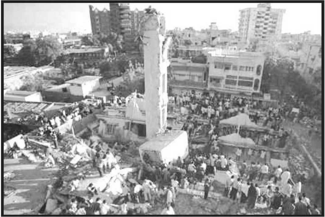
Şekil 3.8 : Deprem sonrası yıkılmayan asansör kuyusu [16]
