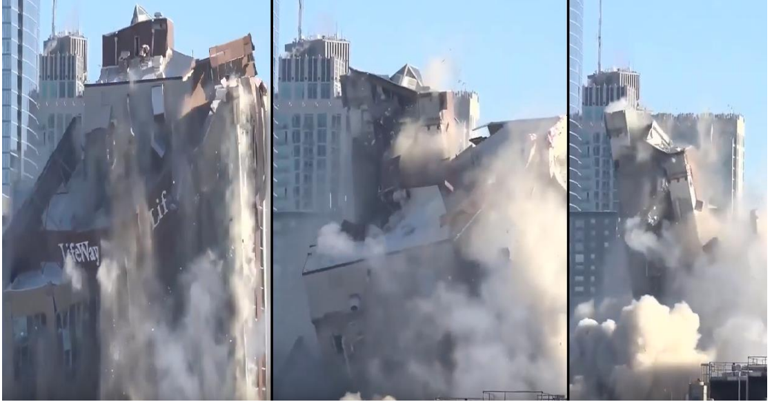
Şekil 3.11 : Dinamitle patlatılan binanın asansör kuyusunun sonradan tek parça olarak yıkılması [19]
