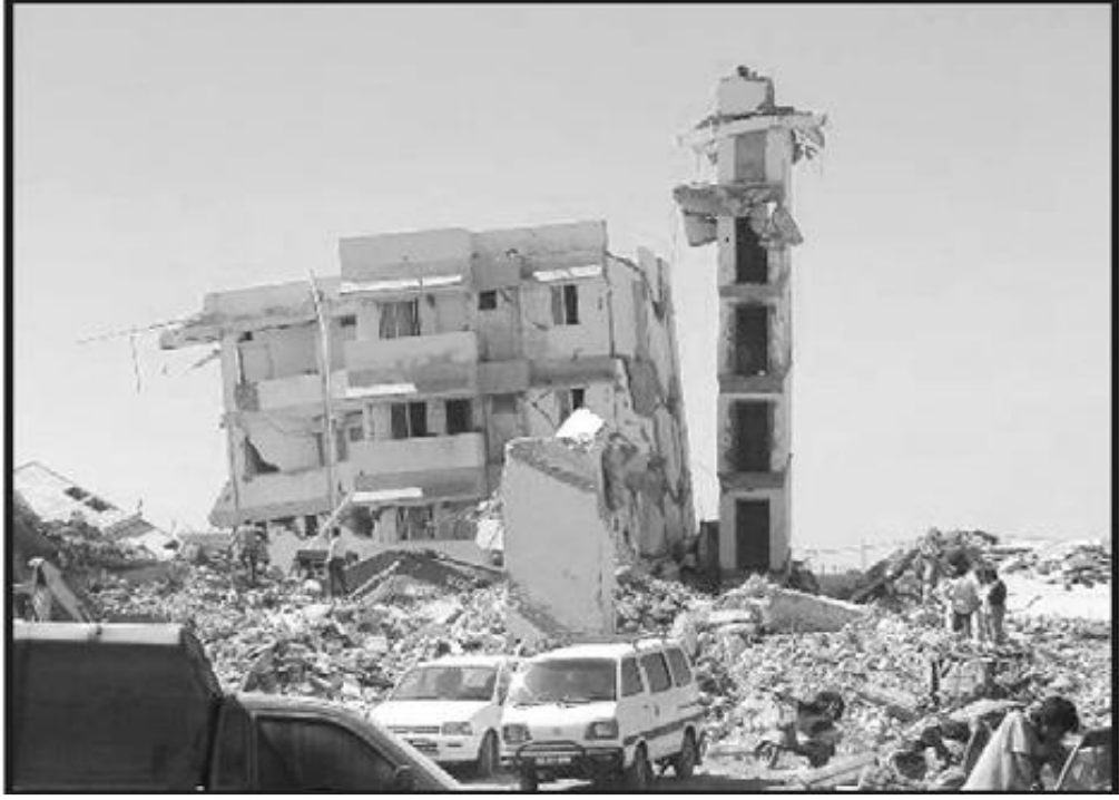
Şekil 3.7 : Deprem sonrası yıkılmayan asansör kuyusu [16]
