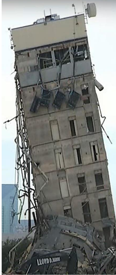
Şekil 3.9 : Dallas'ta yıkılan binanın asansör kuyusunun yıkılmaması [17]
