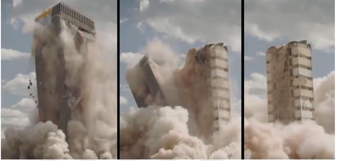
Şekil 3.10 : Dinamitle patlatılan binanın asansör kuyularının yıkılmaması [18]
