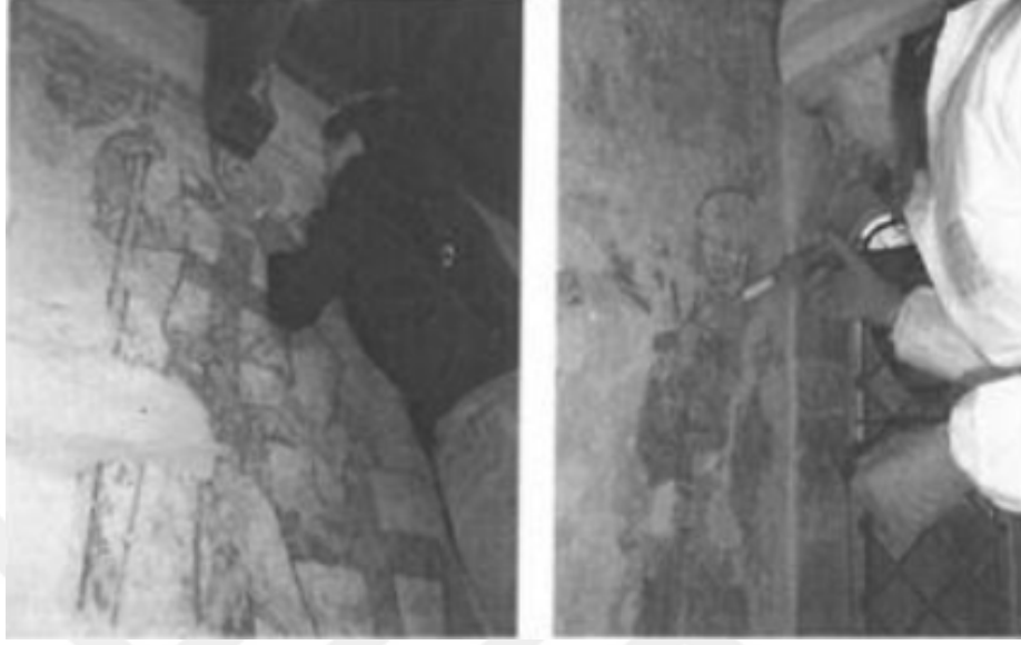
Şekil 5.29 Enjeksiyon yöntemiyle nanoteknolojik malzeme uygulaması (Elborombaly, 2016)
