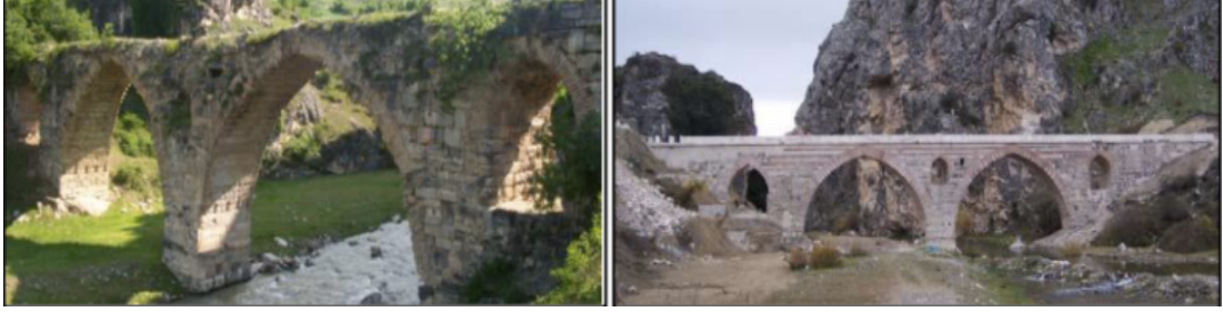
Şekil 5.9 Tarihi Kurt Köprüsü'nün onarımı öncesi ve sonrası görünümü (Maraş ve diğer., 2016)
