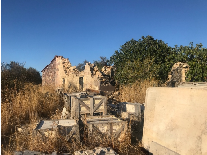
Şekil 6.39 Yağhanenin yıkılmış durumdaki beden duvarları (Kişisel arşiv, 2019)
