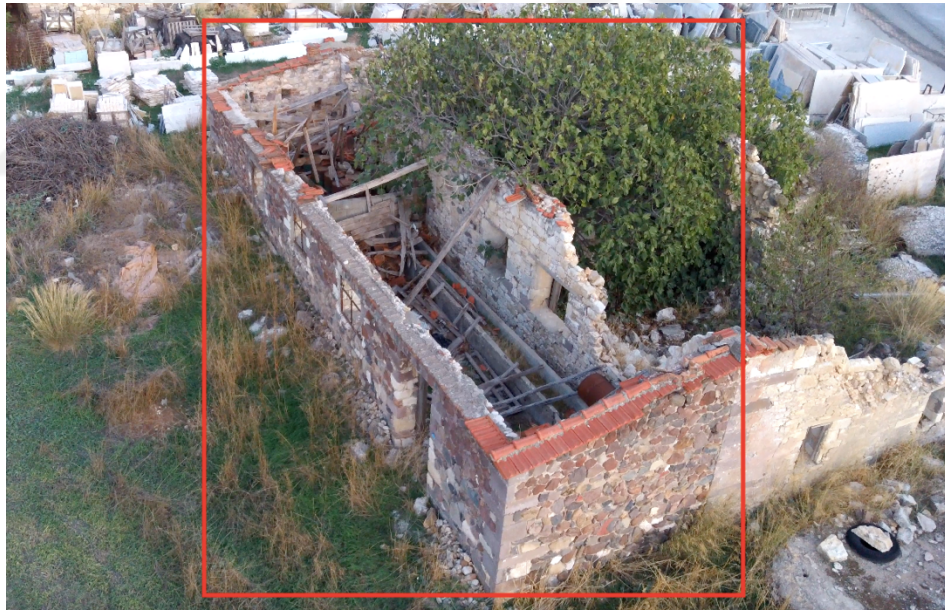
Şekil 6.59 İkinci dönem eklenen beden duvarları (Kişisel arşiv, 2019)
