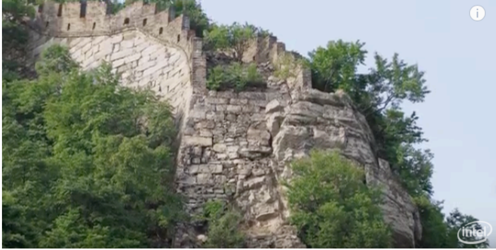
Şekil 5.13 Çin Seddinin Jiankou bölümünde oluşan hasarlar ve eksilmeler (Intel, 2019)
