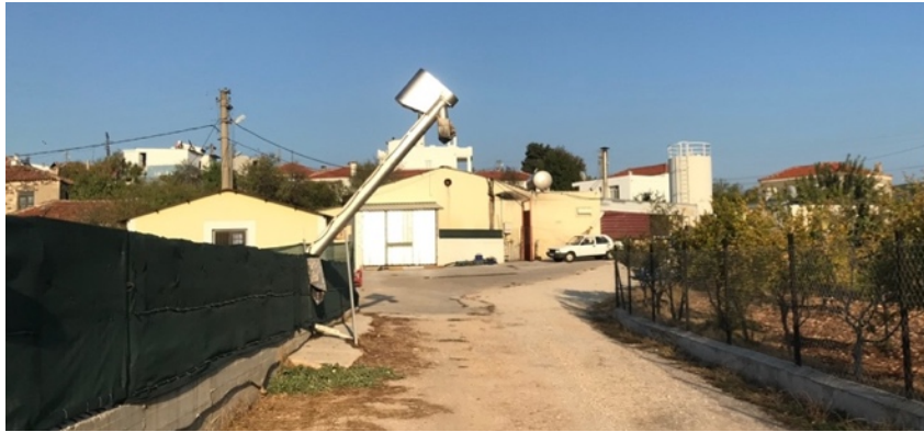
Şekil 6.29 Yeni yağhane yapısında kullanılan makineler (Kişisel arşiv, 2019)
