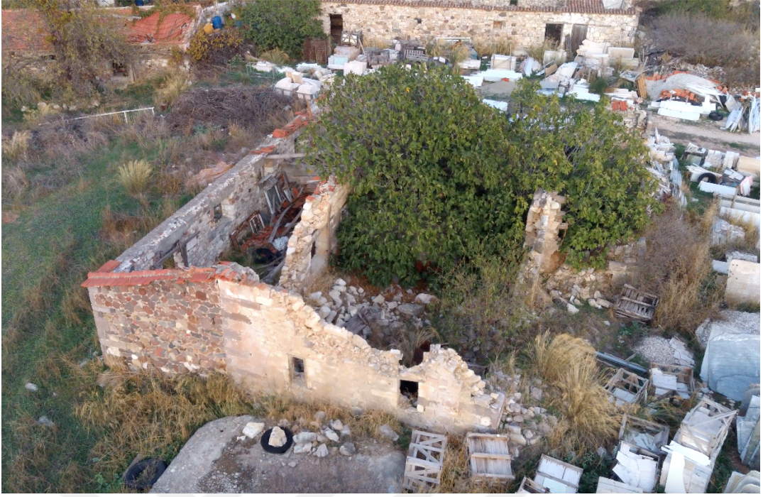
Şekil 6.47 Yağhane Yapısının Drone ile Çekimi (Kişisel arşiv, 2019)
