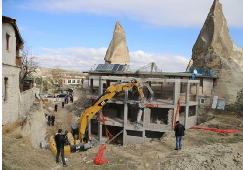
Şekil 3. 17 : Nevşehir, Göreme, 4923 nolu parseldeki ruhsatlı yapının yıkımı (Url-13).
