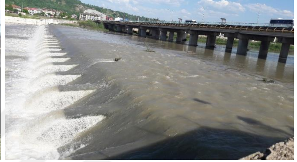
d) Çaycuma köprüsü mansabında düşülü brit yapısına ait görüntü.
