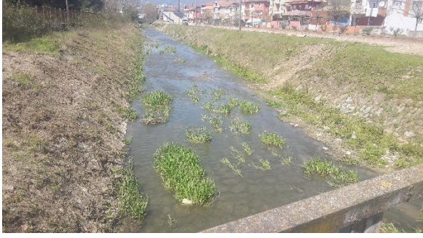
a) Köprü mansap yönünde şev koruma yapısı ve taban kaplama anroşmanı görünümü.
