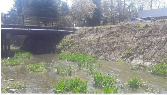
c) Mansap sol sahil harçlı pere şev kaplaması görünümü.
