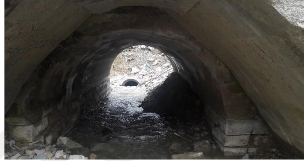
d) Taşkın sonrası temizlenerek akışa uygun hale getirilen kemer köprüye ait görüntü.
