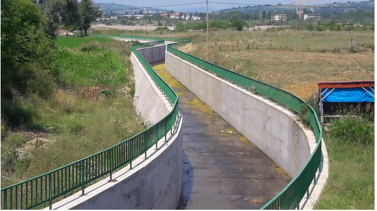
Şekil 2.10 Filyos Çayına sol sahilden mansaplanan Abdalpaşa Deresi taşkın koruma inşaatı.
