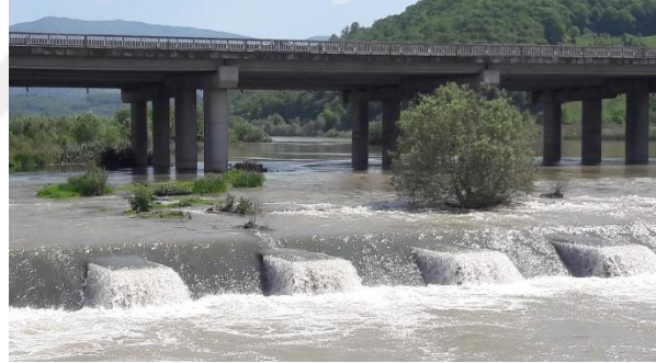
f) Köprü mansabında inşa edilmiş düşülü beton brit yapısına ait görüntü.
