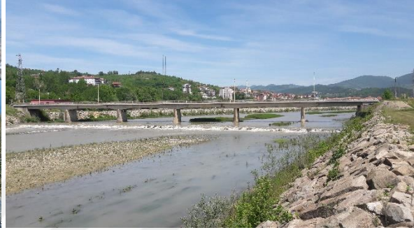
d) Köprü kenar ayakları memba ve mansap yönünde tahkimat kaplanarak güçlendirildi.
