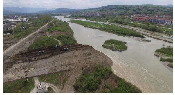
b) Uygun hidrolik akış kesidini sağlamak amacıyla yapılan çalışmalara ait görüntü.
