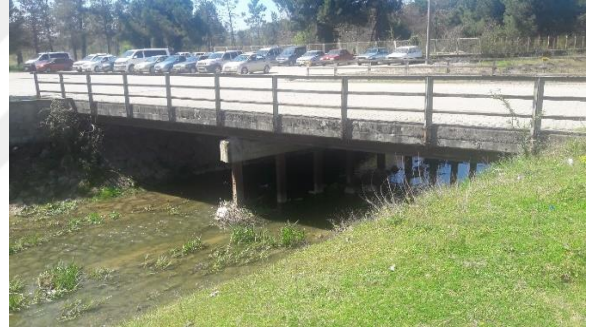
f) Yatak temizlik çalışması sonrası köprü hidrolik kesidi uygun duruma getirilmiştir.
