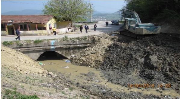
e) Taşkın sonrası makineli tanzim çalışması ile açılan dere yatağına ait görüntü.
