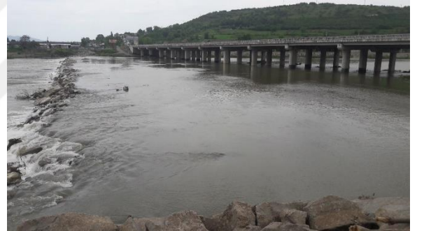
f) Köprü mansabında inşa edilmiş bit yapısının yerden görüntüsü.
