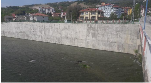
e) Memba yönünde köprü ayağı sol sahil ricat bağlantı duvarına ait görüntü.
