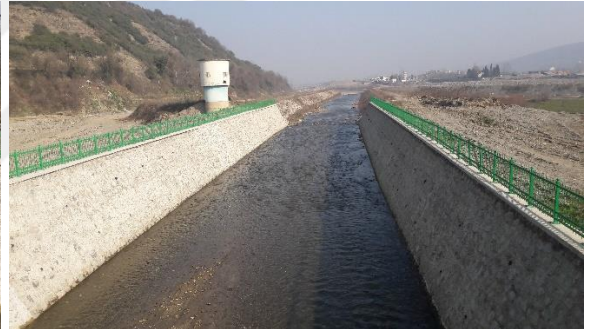
f) Köprü mansap yönünde yatak tanzimi sonrası suyun düzgün akışına ait görüntü.
