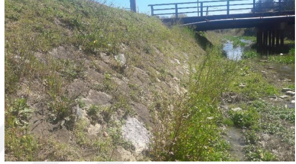
d) Mansap sağ sahil harçlı pere şev kaplaması görünümü.
