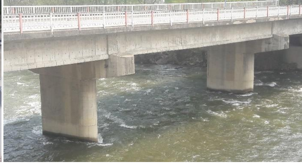
f) Köprü üç açıklıklı ve iki orta ayaklı olarak inşa edilmiştir.
