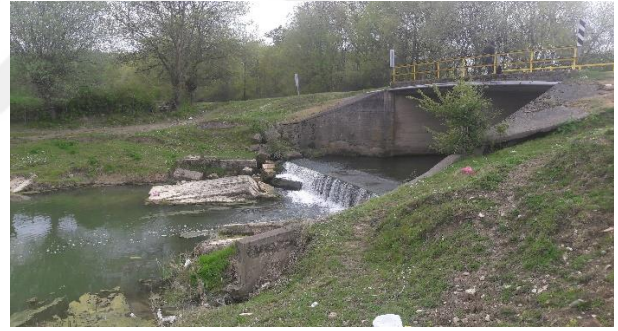
f) Çorak köprüsü tabanındaki beton kaplama ve brit yapısı.
