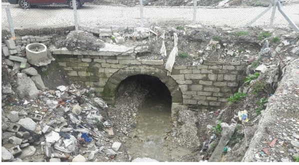
a) Devrek İlçesi Karşıyaka Mah. Kaldırım deresi üzerindeki tarihi kemer köprü.
