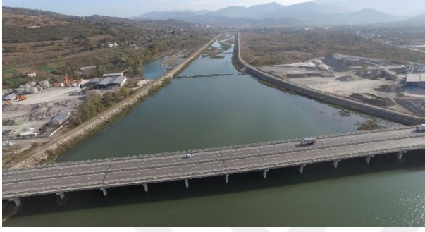
c) Köprü membasında her iki yamaçta şevlerin tahkimatlı korumasına ait drone görüntüsü.
