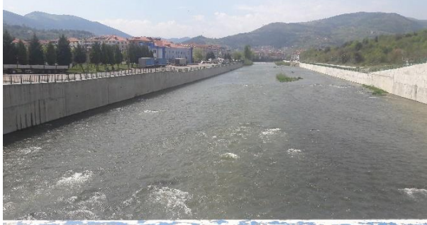
c) Köprü membasına doğru her iki şevi koruma altına alınmış dereye ait görüntü.
