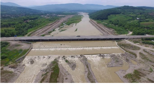
a) Bakacakkadı köprüsü mansap yönünde düşülü brit yapısına ait drone görüntüsü.
