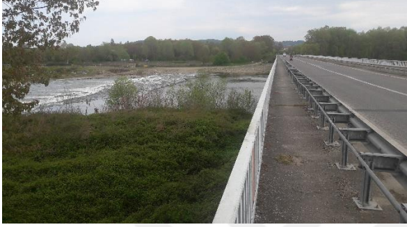
c) Mansap kısmında şev korumasına yönelik mühendislik yapısı inşa edilmemiştir.
