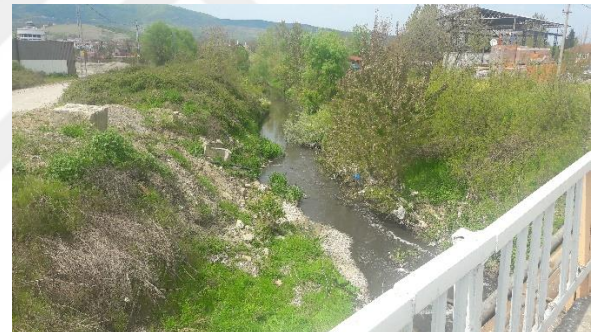
f) Membada olduğu gibi mansap yönünde de herhangi bir kıyı koruma yapısı yoktur.
