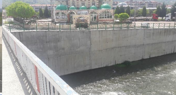
d) Memba yönünde köprü ayağı sağ sahil ricat bağlantı duvarına ait görüntü.
