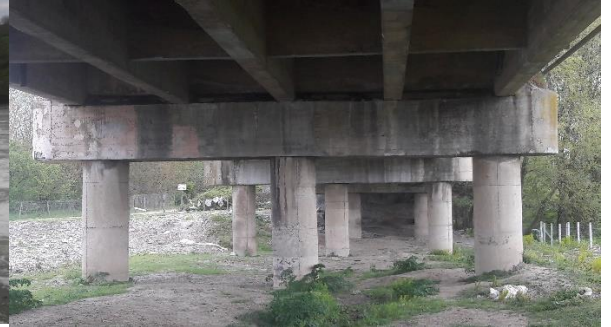
f) Saltukova köprüsünde kullanılan basit giriş sistemine ait görüntü.
