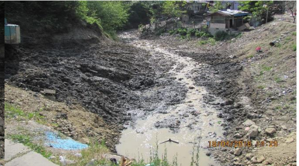
f) Taşkın koruma tedbirlerinin alınması gereken köprü memba kısmına ait görüntü.
