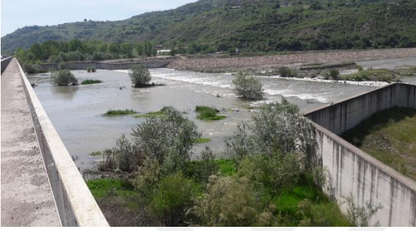
c) Bakacakkadı köprüsü mansap sağ sahil ricat duvarına ait görüntü.
