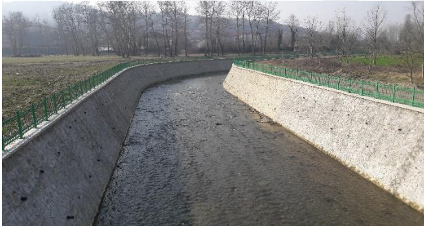
e) Köprü memba yönünde yatak tanzimi sonrası suyun düzgün akışına ait görüntü.
