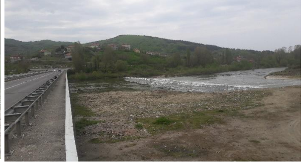
b) Memba kısmında şev korumasına yönelik mühendislik yapısı inşa edilmemiştir.
