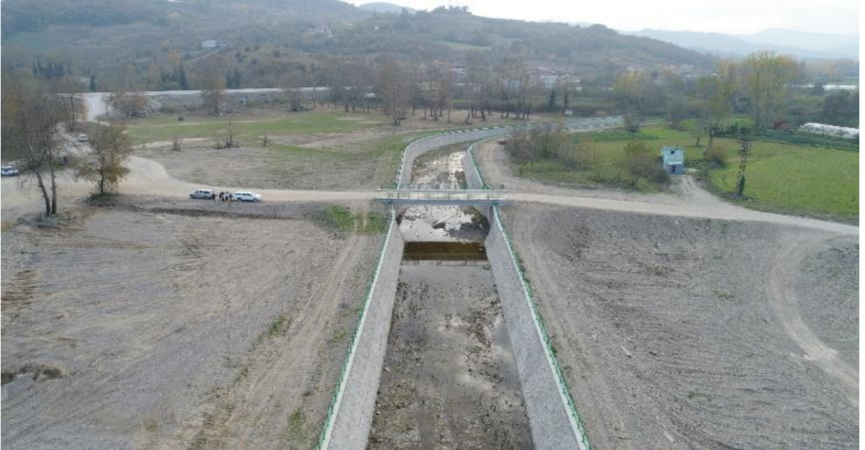
Şekil 2.12 Filyos Çayına sol sahilden mansaplanan Örmeci Deresi taşkın koruma inşaatı.
