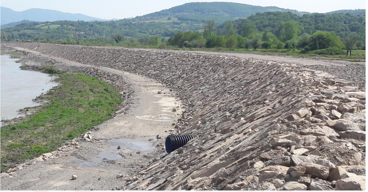
Şekil 2.11 Filyos Çayı Sol Sahilden OSB önünde yapımı tamamlanan taş tahkimat imalatı.
