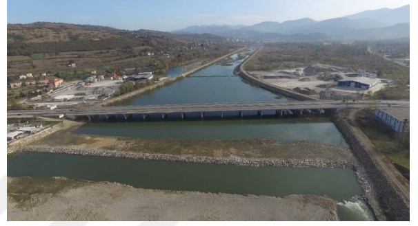
d) Köprü ayaklarını oyulmaya karşı koruyan mansaptaki bit yapısına ait drone görüntüsü.
