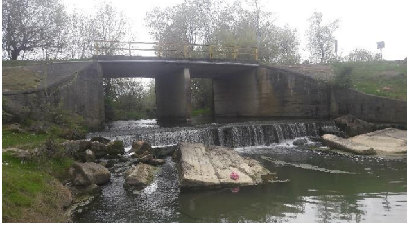
a) İki açıklıklı Çorak köprüsünün mansaptan görüntüsü.
