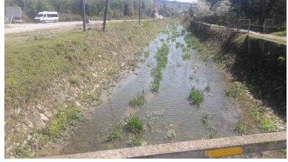
b) Köprü memba yönünde şev koruma yapısı ve taban kaplama anroşmanı görünümü..
