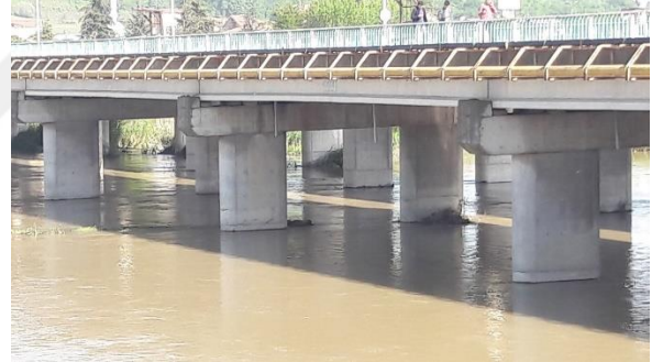
f) Çaycuma köprüsü ayaklarının mansap yönünden görüntüsü.
