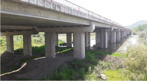
e) Bakacakkadı köprüsü orta ayaklarına ait görüntü.
