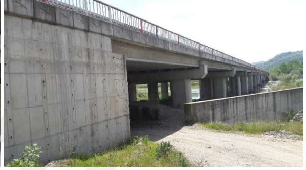
d) Bakacakkadı köprüsü sağ sahil kenar ayağı mansap yönü görüntüsü.
