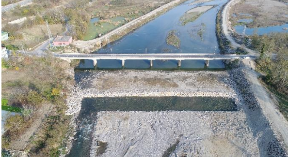
a) Mansap yönünde köprüyü oyulmaya karşı koruyan brit yapısına ait drone görüntüsü.
