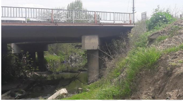
c) Kenar ayak şevlerinin korumasız olması köprü emniyetini olumsuz etkilemektedir.
