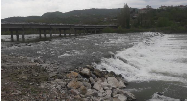
e) Köprü mansabında inşa edilen taş tahkimatlı brit yapısı.
