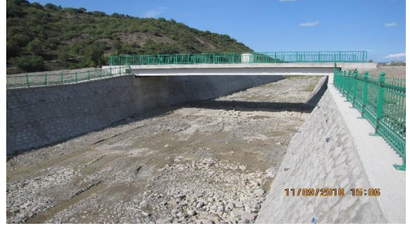
b) Köprü memba sağ ve sol sahilde kagir duvar ayak bağlantıları.
