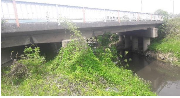
a) Perşembe deresi üzerindeki TCK köprüsünün memba yönünden görüntüsü.
