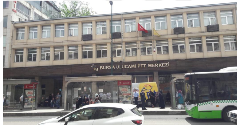
Şekil 3.37. Bursa Ulucami PTT Binası.
