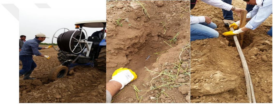
Şekil 3.11 YADS sistem laterallerinin döşenmesi
