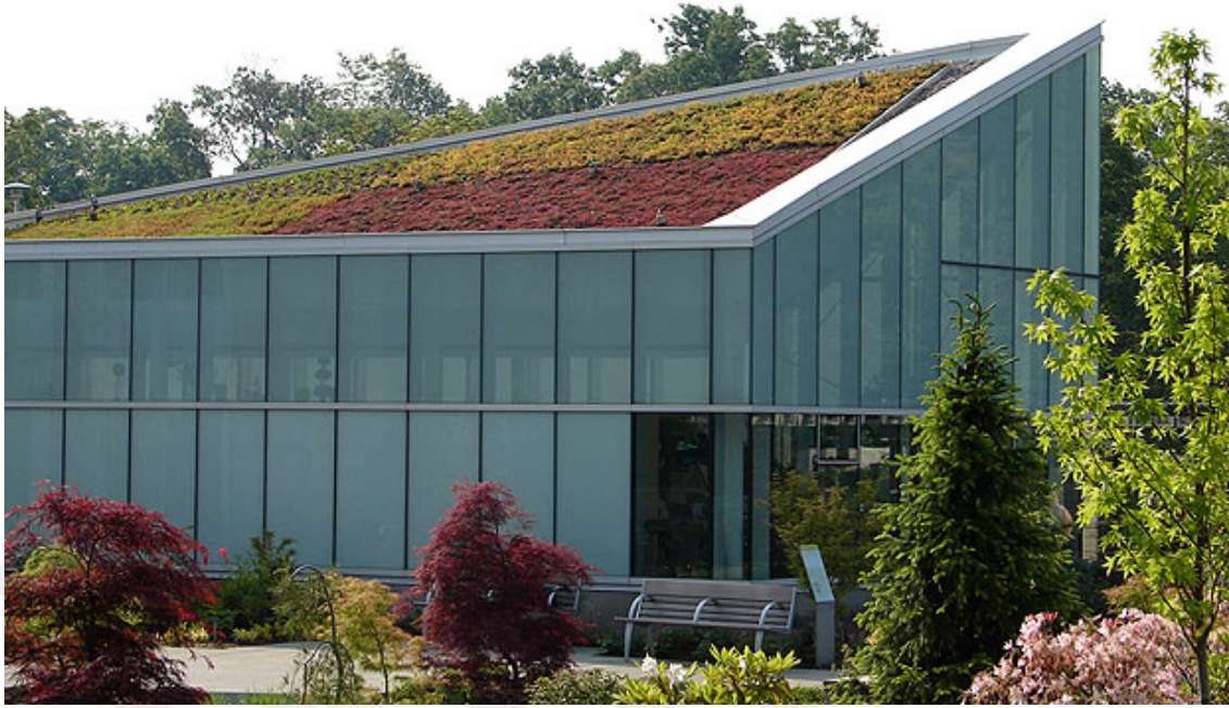
Şekil 4.11: Toronto yeşil çatılar projesi uygulama örnekleri 3 (Url-12).
