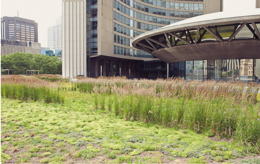
Şekil 4.10: Toronto yeşil çatılar projesi uygulama örnekleri 2 (Url-11).
