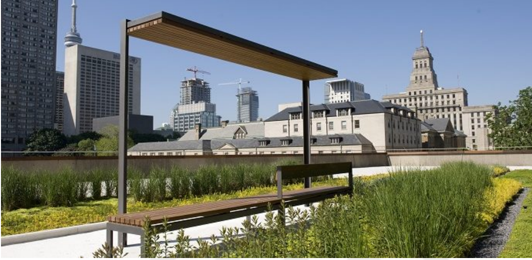
Şekil 4.9: Toronto yeşil çatılar projesi uygulama örnekleri 1 (Url-10).
