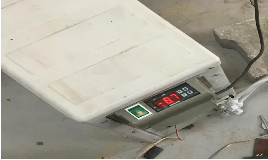
Şekil 3.7. Soğutma sistemi kontrol paneli.
