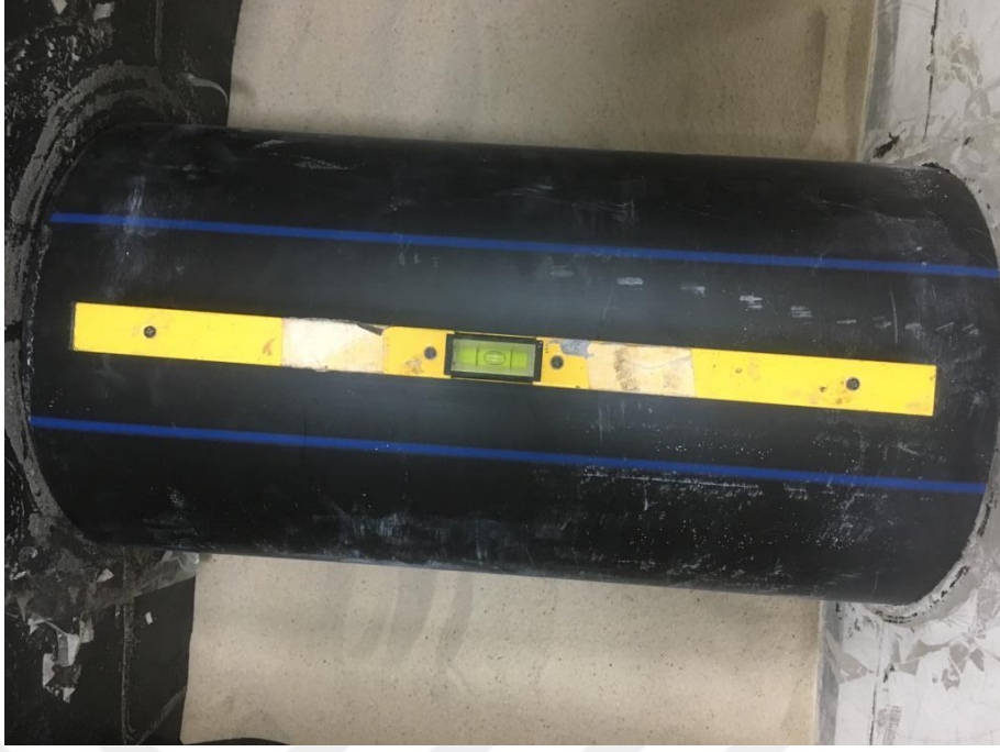
Şekil 3.3. HDPE borunun yerleşimi.
