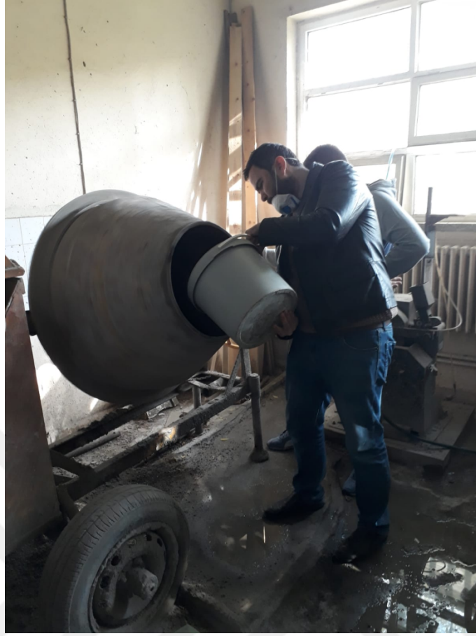
Şekil 3.1 Beton karışımının hazırlanması
