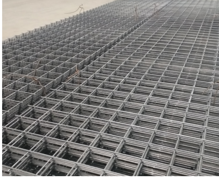
Şekil 2.7 Kaynaklı hasır donatı
