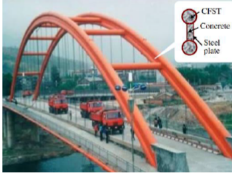
Şekil 2.1 CFST ile tasarlanan Wangcang East River Köprüsü (Han ve ark., 2014)
