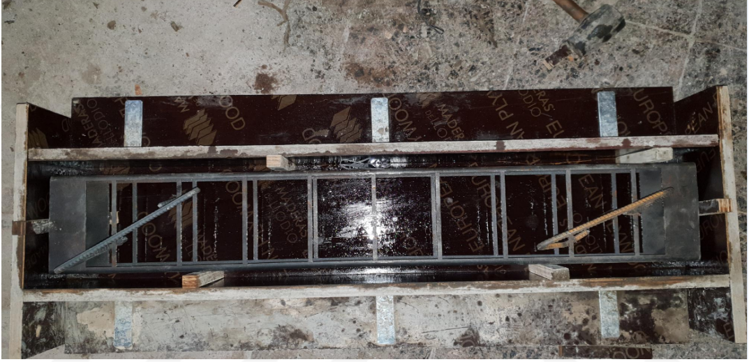
Şekil 3.15 Kalıp içerisinde prefabrik donatı
