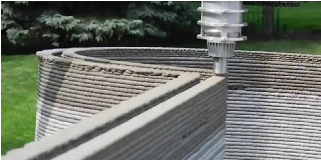
řekil 31: 3b baskıda beton kullanımı
