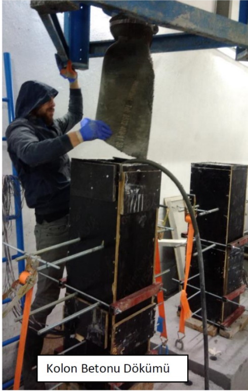
Şekil 2.3 S351008-S352008-S353508 kolonlara ait imalat fotoğrafları
