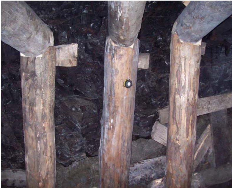
Resim 5.5. 2 nolu kömür ocağı içerisine yerleştirilen detektör.
