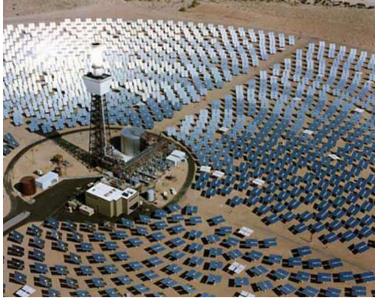
Şekil 1.29. Heliostat sistem (Soteris, 2009)
