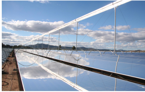
Şekil 1.25. Fresnel yansıtıcı sistem (Anonim, 2010)
