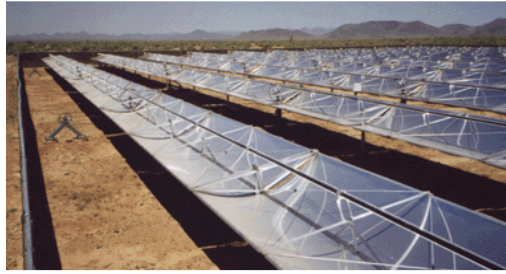
Şekil 1.20. Parabolik oluklu güneş kolektörü (Soteris, 2009)
