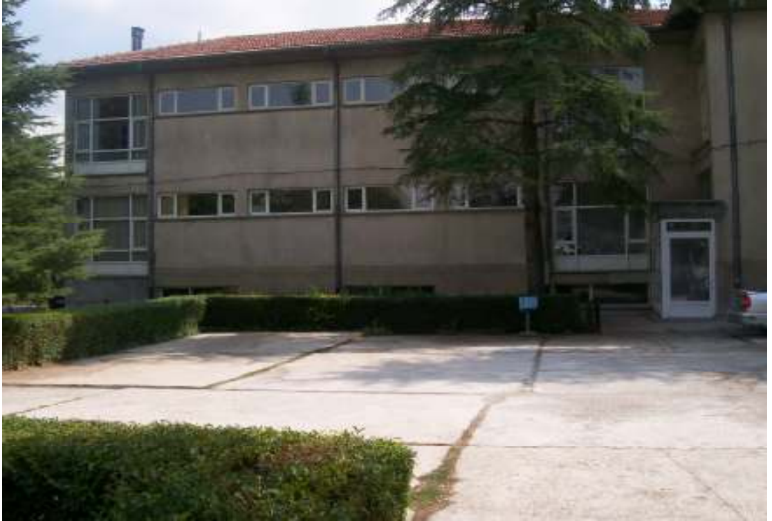
Fotoğraf 4. Konya Veteriner Kontrol ve Araştırma Enstitüsü araştırma bölümü (arka bina batı cephesi).
