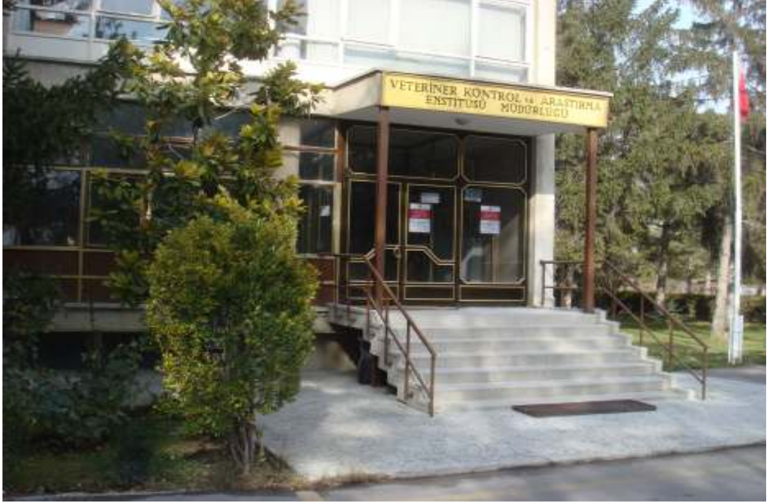
Fotoğraf 3. Konya Veteriner Kontrol ve Araştırma Enstitüsü ana bina genel girişi (güney cephe).
