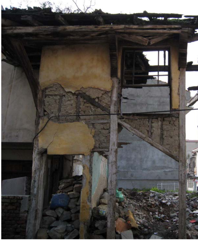
Ek- 5 Nushetiye Sokak'ta kerpiç malzemeden inşâ edilmiş iki katlı bir ev
