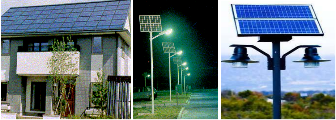
Resim 3.1. Güneş enerji sistemleri
