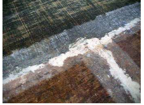
Resim 54- Zamkla sertleştirilen dikişin kazınması Resim 55- Onarılan dikiş alanı
