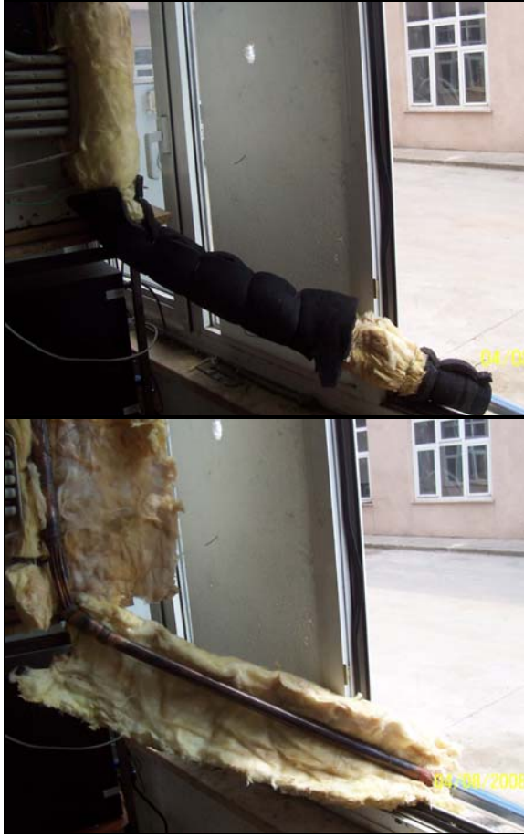
Resim 4.14. YSS2 sistemlerinde ısı borusunun bağlantısı ve yalıtımı.
