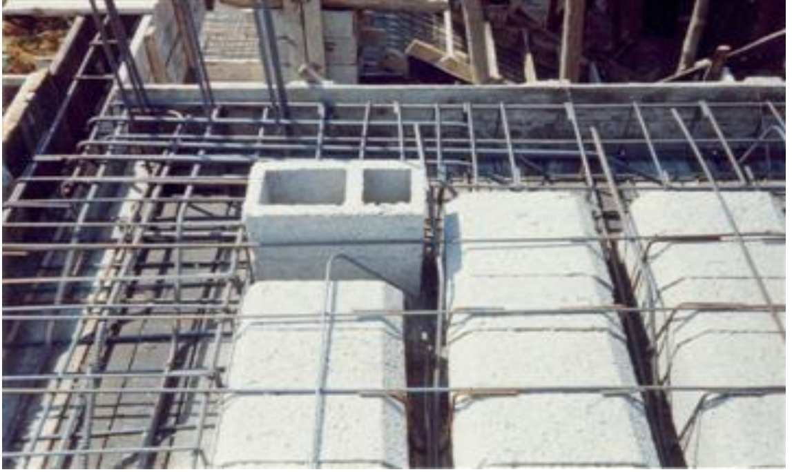
Şekil 4.27 Dolgu Bloklı Dışlı Döşemelerde Baca Yerleştirilmesi
