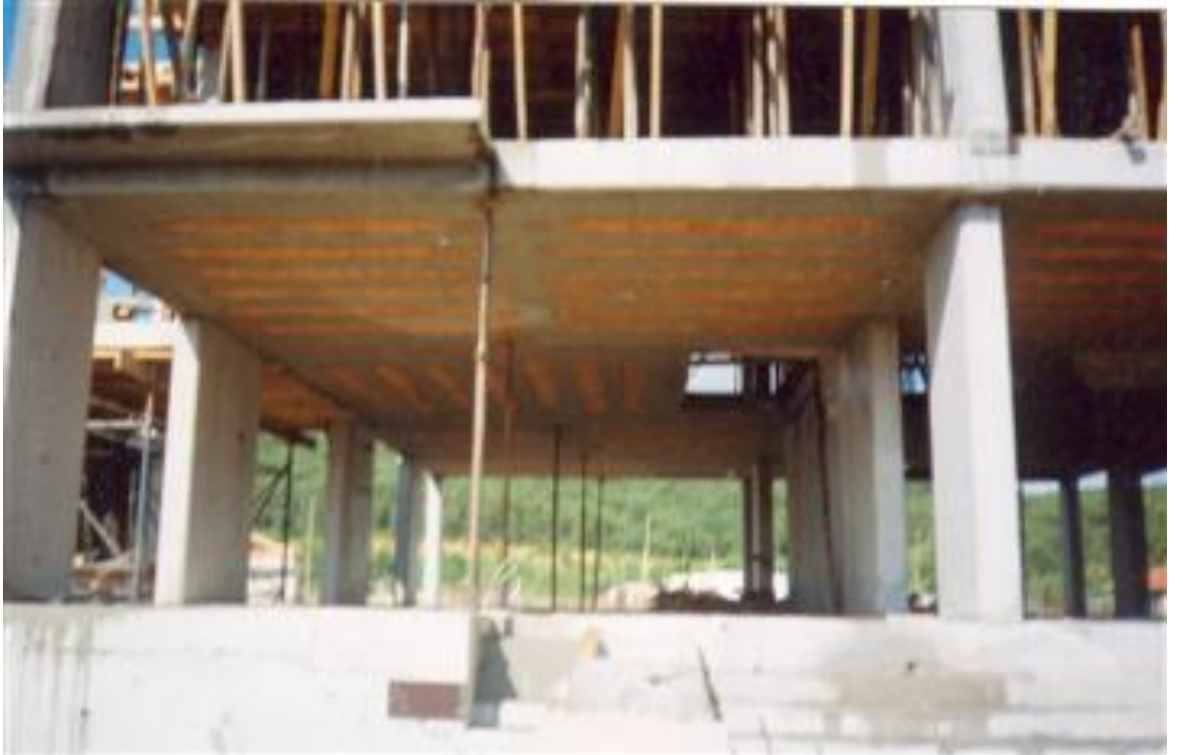
Şekil 2.12 Bir Doğrultuda Çalışan Dolgu Bloklü Dişli Döşemeler
