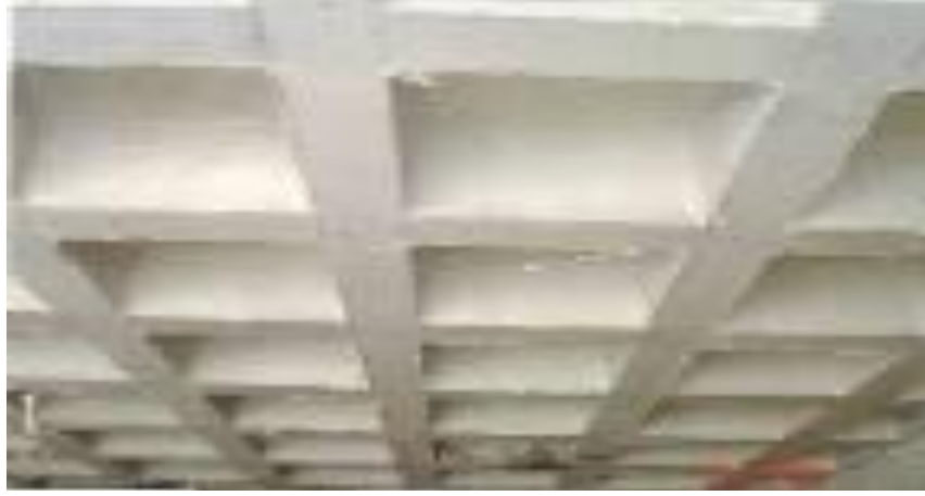
Şekil 2.13 İki Doğrultuda Çalışan Dişli Döşemeler
