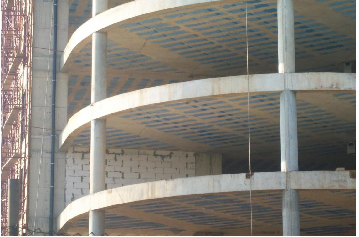
Şekil 4.62 Kalıp Söküldükten Sonra Tavan Görünümü
