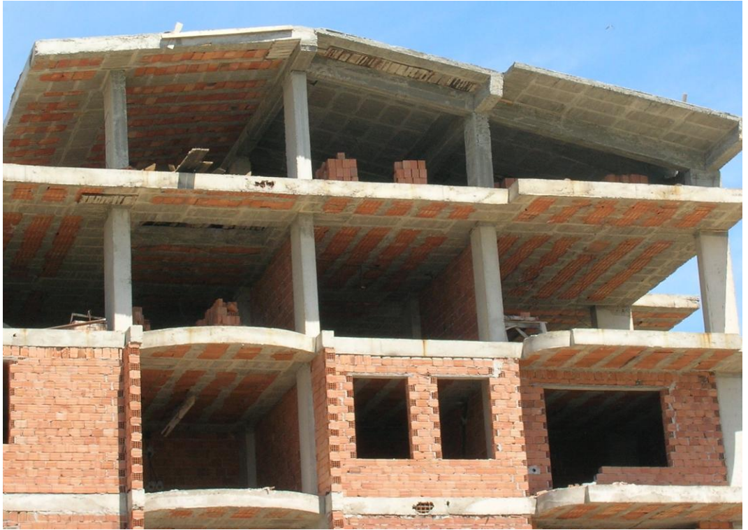
Şekil 4.16 Dolgu Bloklı Dışlı Döşeme Uygulaması
