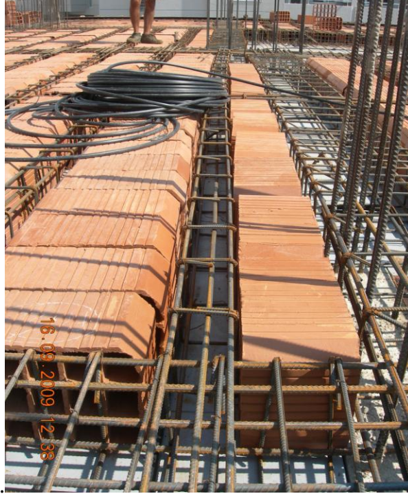
Şekil 4.8 Dolgu Bloklar Yan Dizilerek Veya Kesilip Küçültülerek Yerleştirilebilirler
