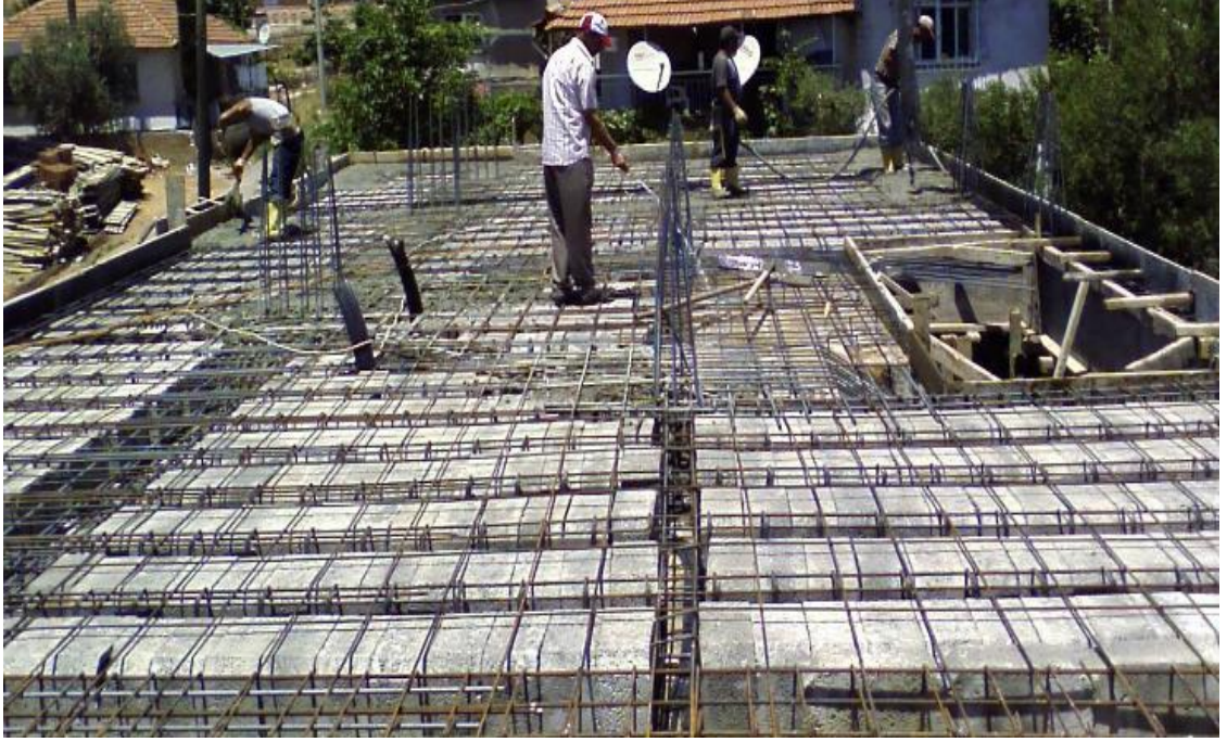
Şekil 4.29 Dolgu Bloklar Ve Donatılar Yerleştirildikten Sonra Döşeme Betonu Dökülmesi
