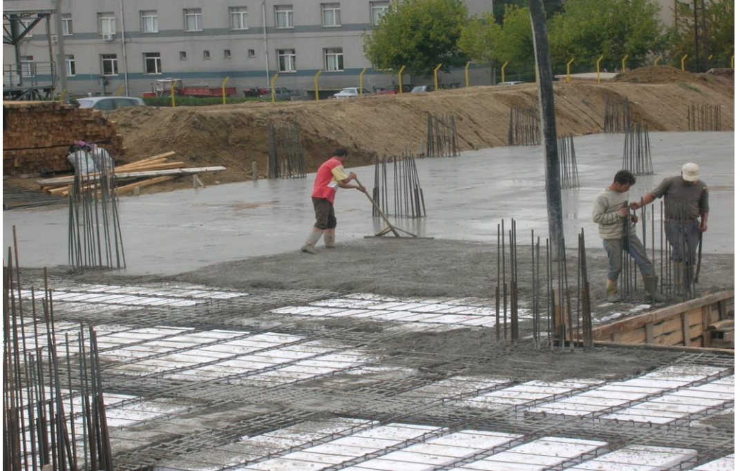
Şekil 4.61 EPS Dolgu Blokların Üzeri 5-7cm Üst Başlık Betonu Kaplanır
