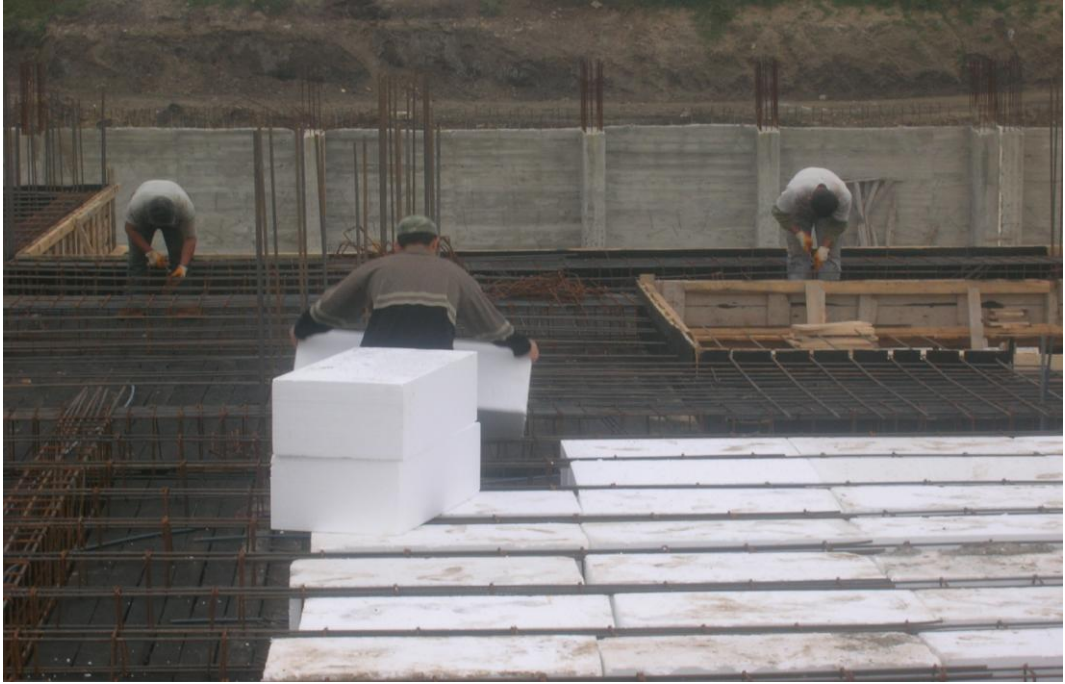
Şekil 4.59 Kalıp Üstü EPS Dolgu Blok Uygulaması
