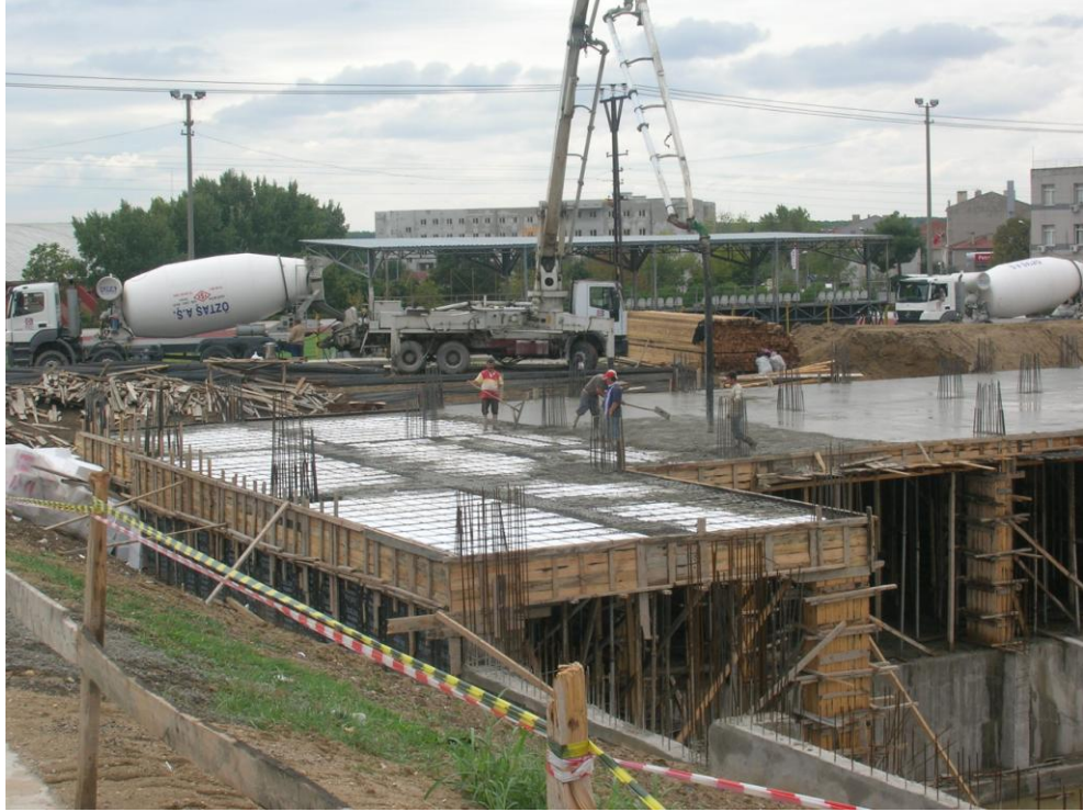
Şekil 4.34 Gazbeton Dolgu Blokların Üzeri 5-7cm Üst Başlık Betonu Kaplanması
