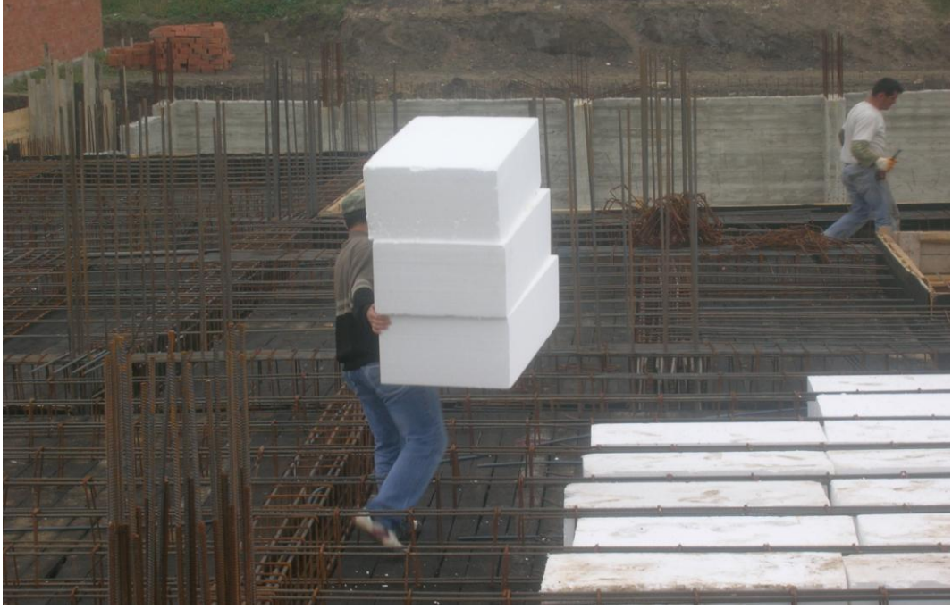
Şekil 4.58 EPS Blokların Taşınması
