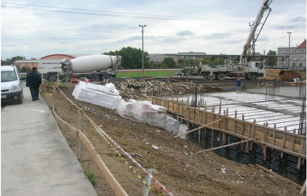
Şekil 4.57 İnşaat Alanına Getirilmiş EPS Bloklar
