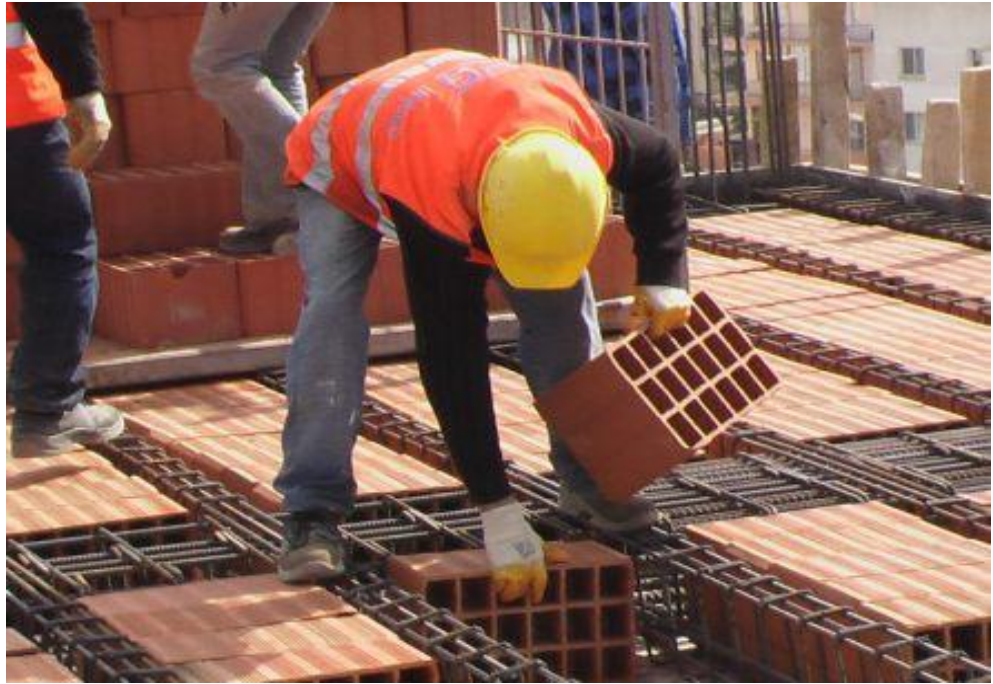
Şekil 4.9 Dolgu Tuğla Bloklar, Delikleri Yatay Konum Alacak Şekilde Yerleştirilmektedir
