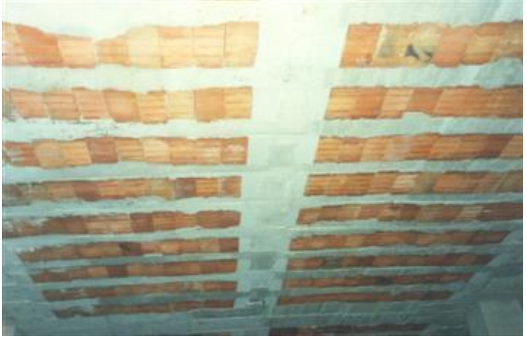
Şekil 4.15 Kalıp Söküldükten Sonra Dolgu Bloklı Dışlı Döşemenin Tavan Görünümü
