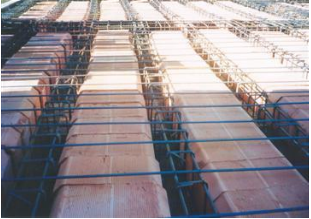
Şekil 4.13 Dolgu Blokların Üzerine Üst Başlık betonu Donatısının Yerleştirilmesi
