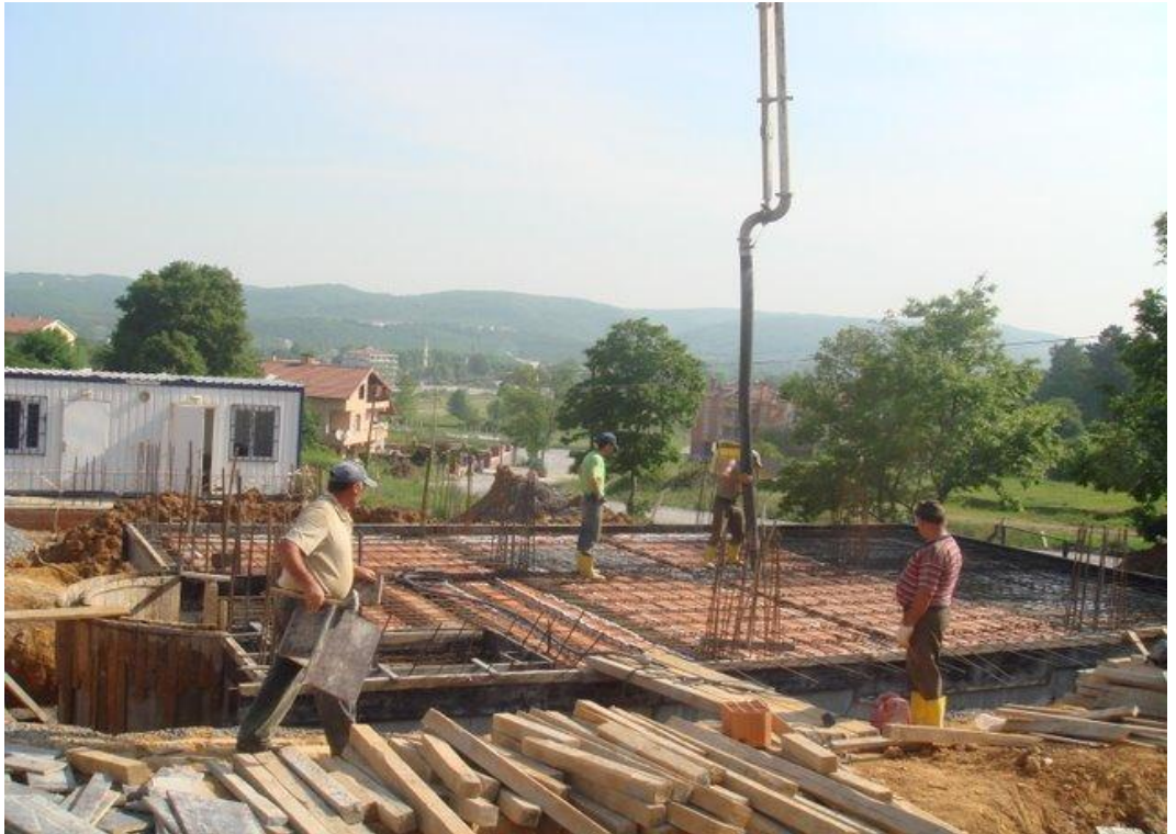
Şekil 4.14 Dolgu Blokların Üzerine Üst Başlık Betonu Dökülmesi
