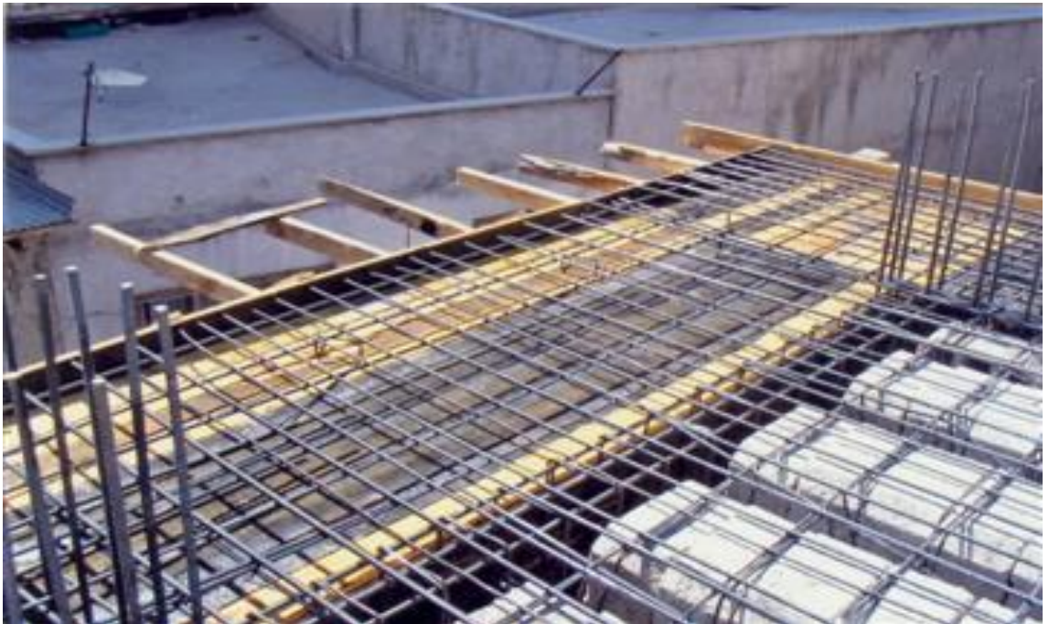
Şekil 4.28 Dolgu Bloklı Dışlı Döşemelerde Balkon Döşemesinde Donatı
