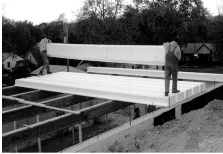
Şekil 4.54 Kalıpsız Dolgu Blok EPS Uygulaması
