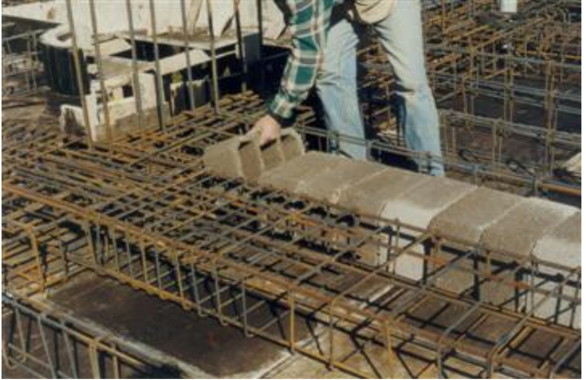
Şekil 4.25 Asmolen Bims Blokların Delikleri Yatay Gelecek Şekilde Dizilmesi
