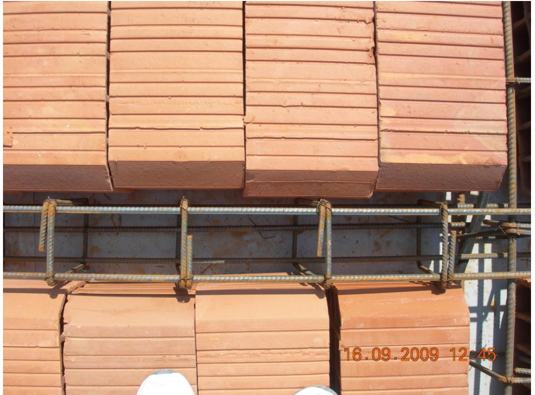
Şekil 3.2 Dolgu Bloklu Dişli Döşemelerde Dişlerin Donatısı
