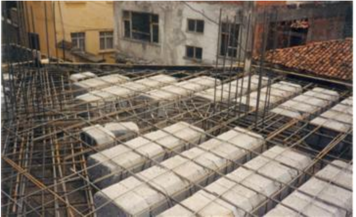
Şekil 4.26 Kapalı Uç Blokların Yerleştirilmesi
