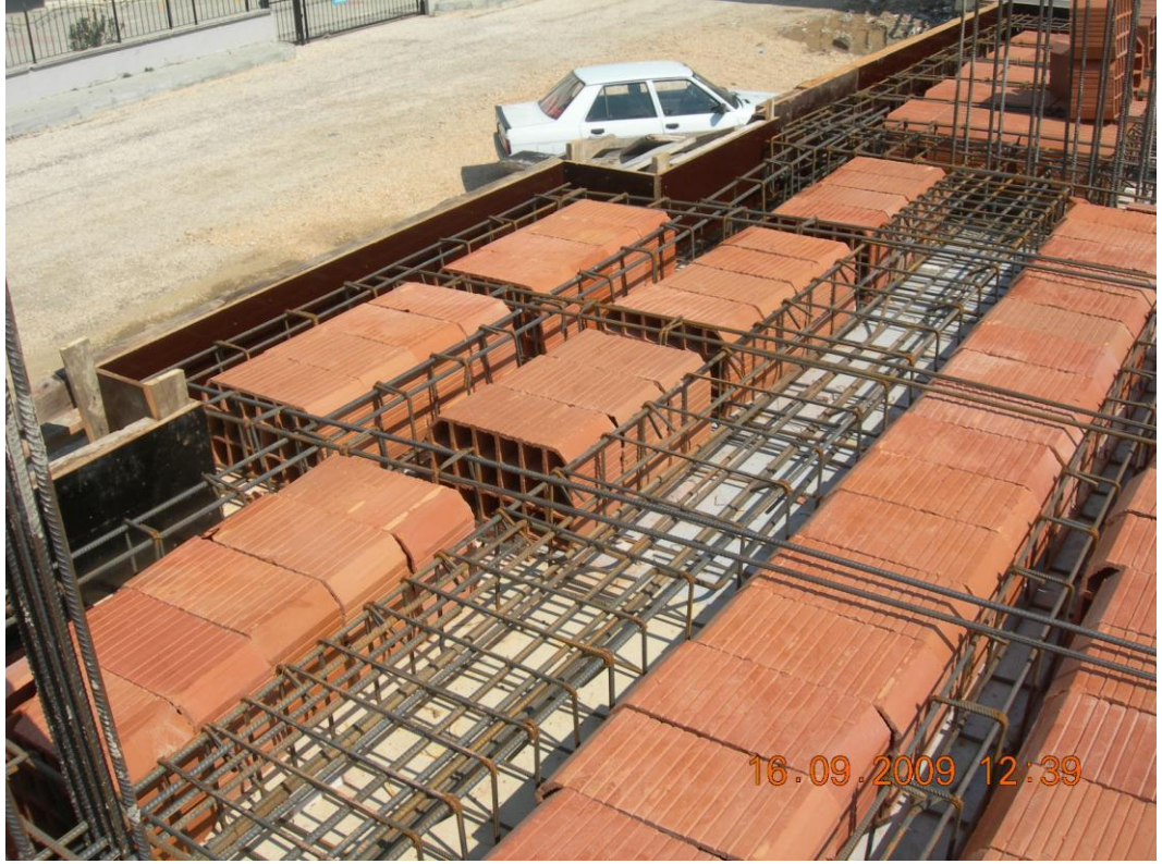
Şekil 3.3 Dolgu Bloklı Dışlı Döşemelerde Ana Kiriş Donatısı
