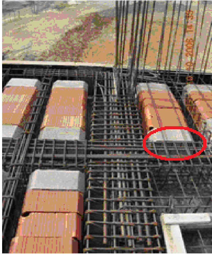
Şekil 4.11 Kapalı Uç Blok Uygulamasında Farklı Malzemelerden Destek Alınması
