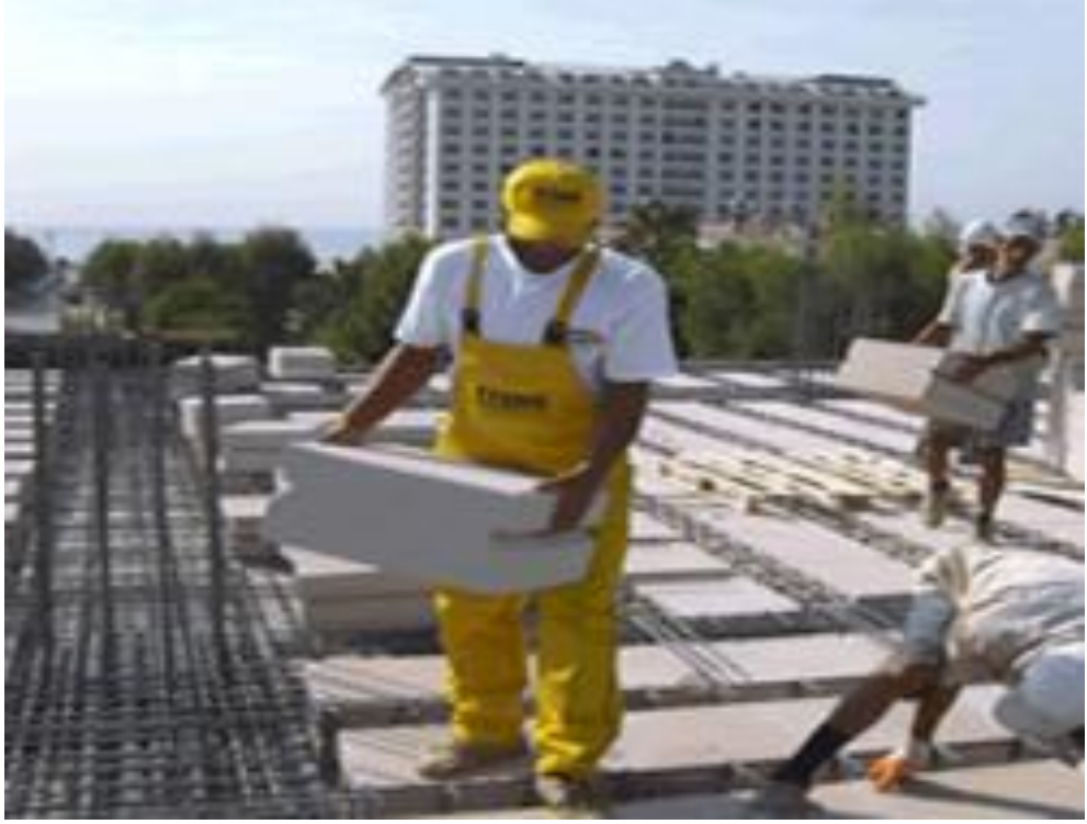
Şekil 4.32 Gazbeton Dolgu Blokların Yerine Terleştirilmesi
