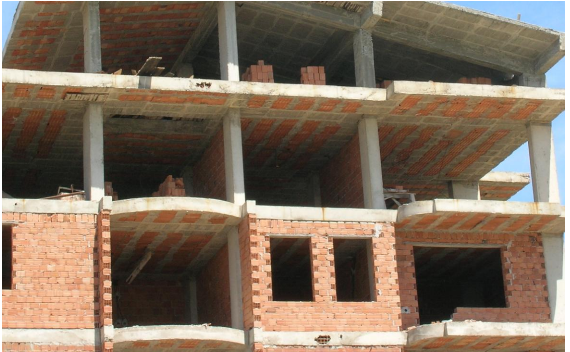
Şekil 3.4 Dolgu Bloklı Dışlı Döşemelerde Taşıyıcı Sistem
