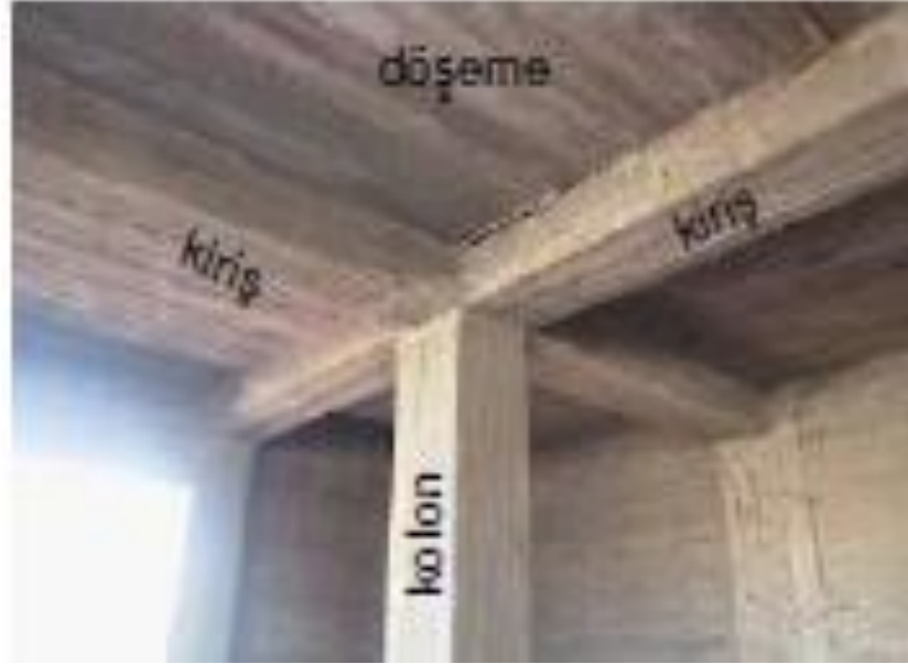
Şekil 2.7 Taşıyıcı sistem elemanları
