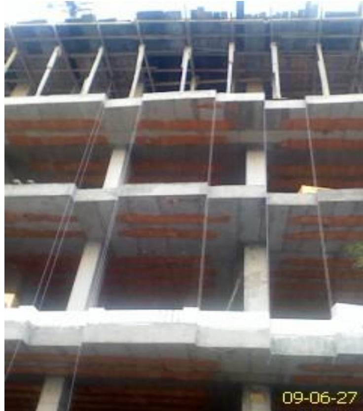
Şekil 2.8 Dolgu Bloklu Dişli Döşeme Örneği
