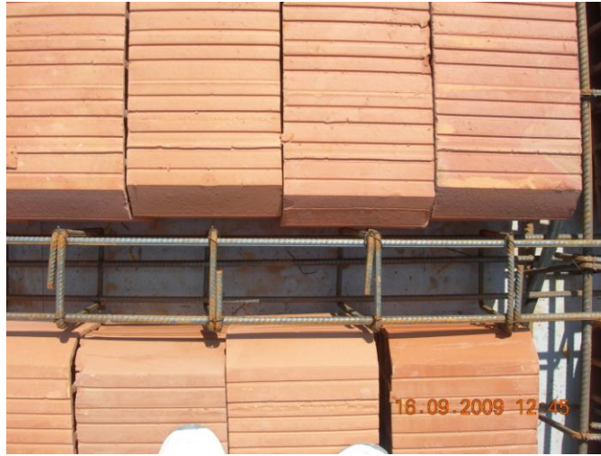
Şekil 4.12 Donatı ile Asmolen Bloklar Arasında Gerekli Payların Bırakılmaması
