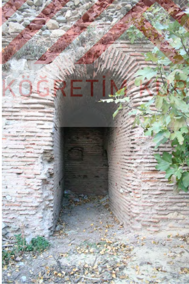
F.186. Tonozlu yan geçişin şehir yönünden görünümü, 2007
