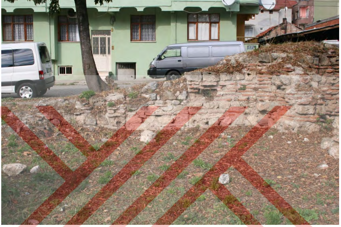
F.52. Narteksin kuzey duvarı ve sonradan örülerek kapatılan kapı, 2009
