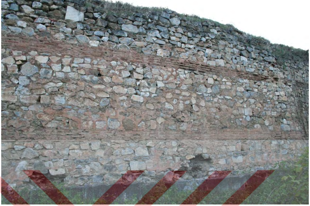
F.185. Lefke Kapı – Top Kapı arasındaki sur duvarından detay, 2007
