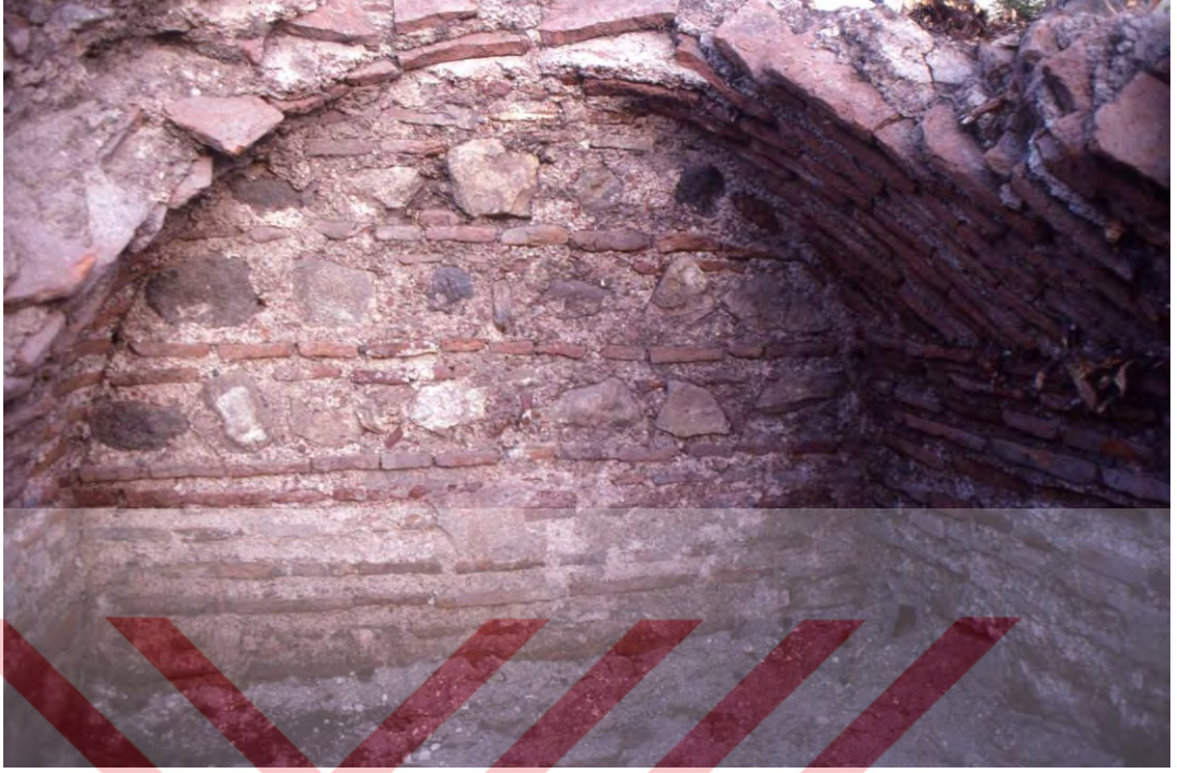
F.103. Yapıdaki iki farklı duvar örgüsüne örnek, 1992 (İÇFK Arşivi)
