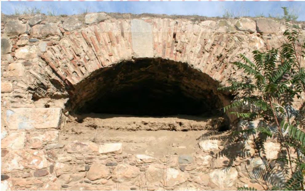
F.162. İki kemer arasındaki kemerli tahliye gözü, 2009
