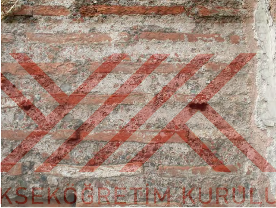
F.30. Kuzey duvarın doğusundan duvar örgüsü detayı ve iki farklı sıvanın izi, 2009
