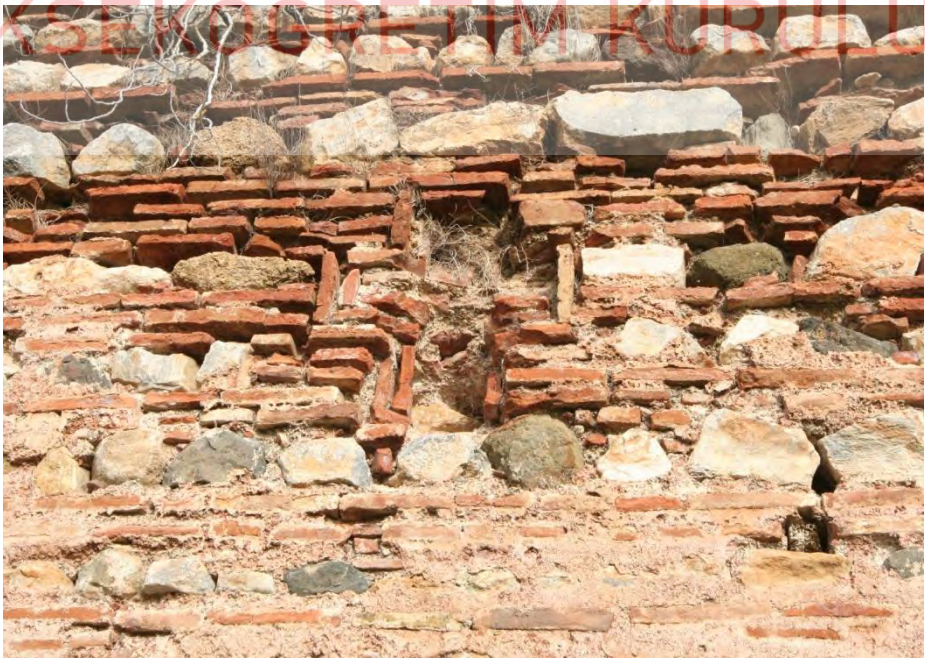
F.199. Yenişehir Kapı yakınında esas sur duvarı üzerindeki haç motifi, 2007
