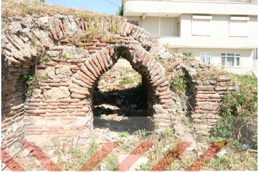
F.62. 6 no.lu odanın doęu duvarının inřa teknięi, 2008
