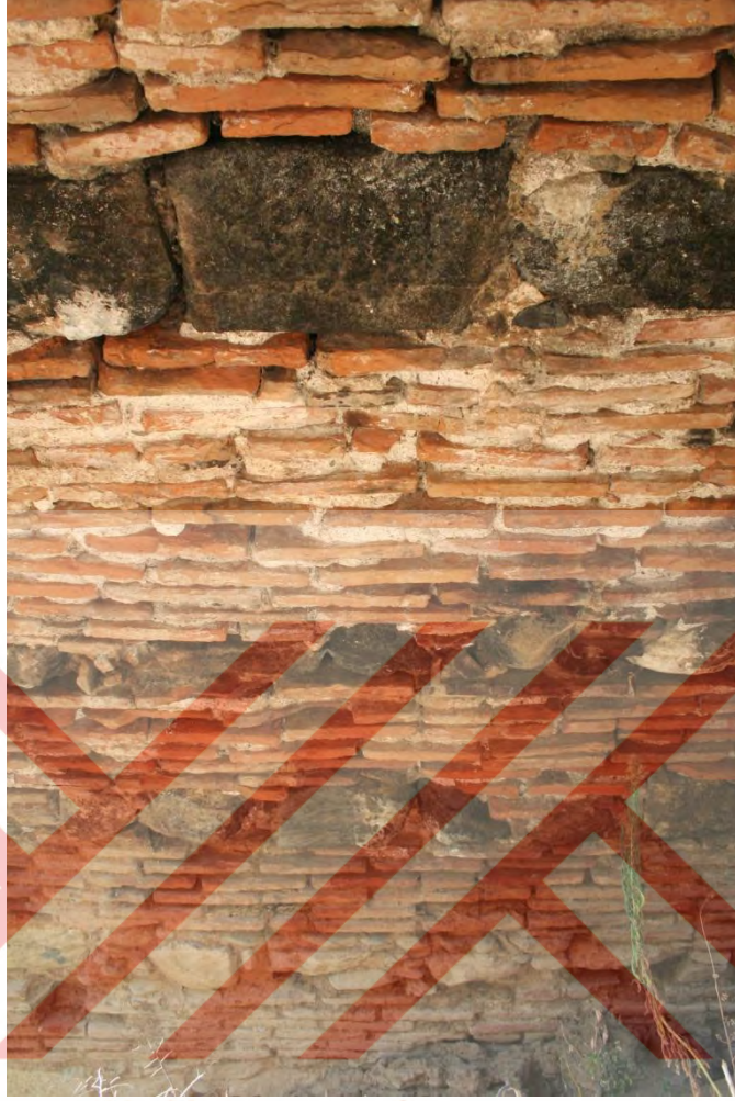
F.161. Kemerin içten görünüşü, 2009
