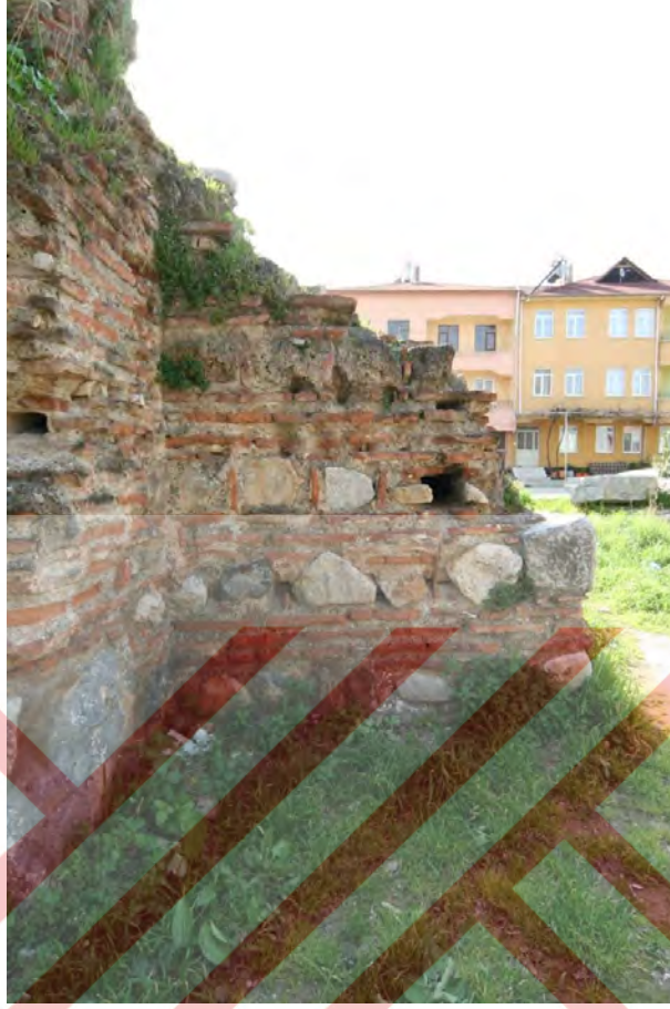
F.50. Naosun batı duvarından duvar örgüsü detayı, 2009
