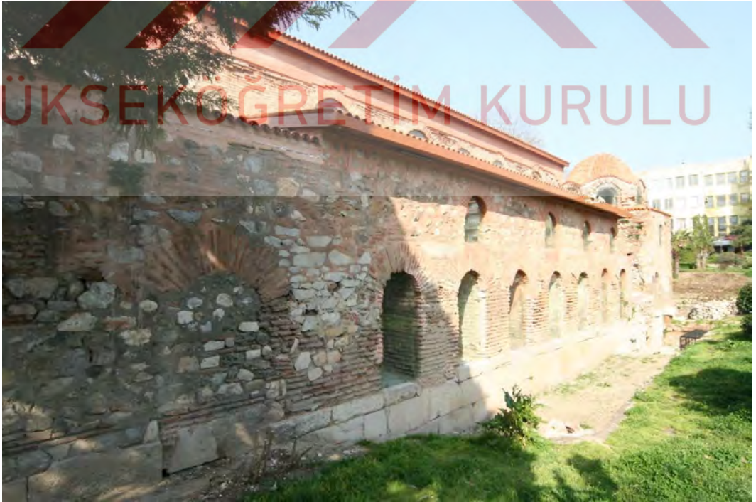
F.12. Restorasyon sonrası güney cephe, 2009
