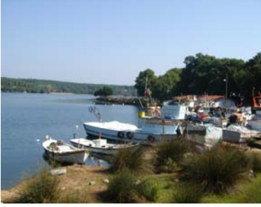
Şekil 4.9. Akliman balıkçı barınağı
