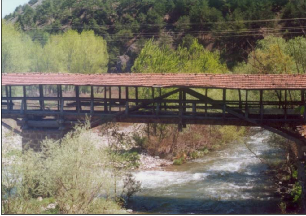
Şekil 4.12 Çaylı Köyü Köprüsü (Anonim 2004)
