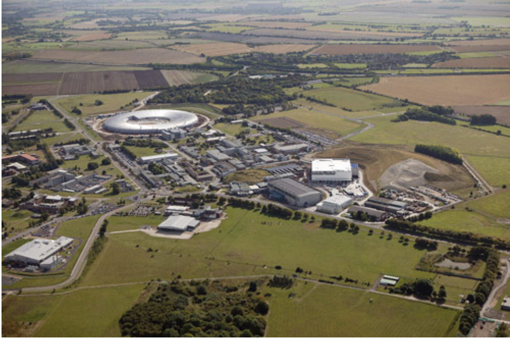
Resim 3.2. Rutherford Appleton Laboratuvarının üstten görünüşü
