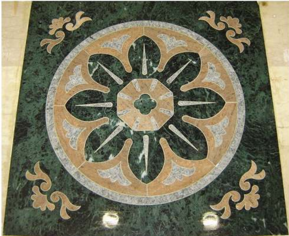
Şekil E2. Mermer Döşeme (Granit – Seramik) Uygulaması
