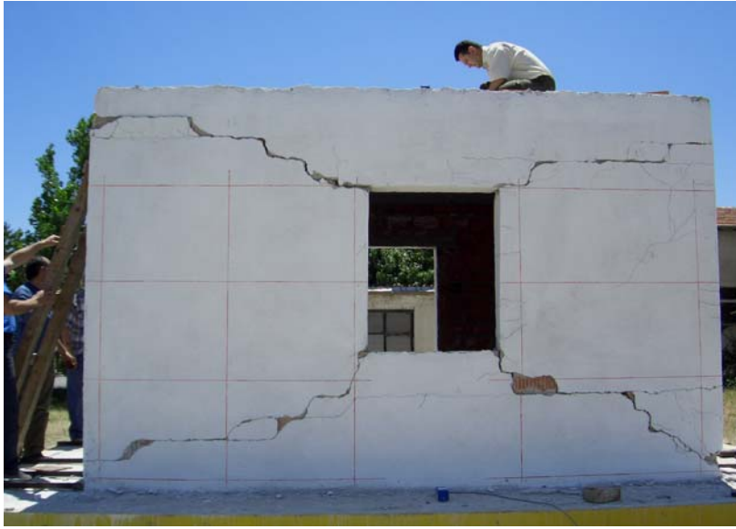
Resim 3.18. Deney Yapısı-1 kuzey cephenin 17. yükleme sonunda görünüşü
