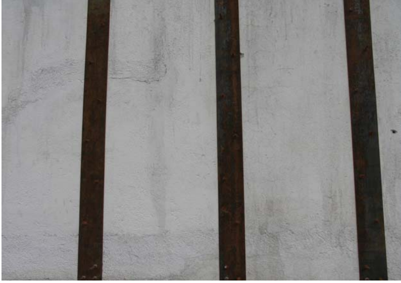
Resim 3.24. Deney Yapısı-2 batı cephenin 18. yükleme sonunda görünüşü
