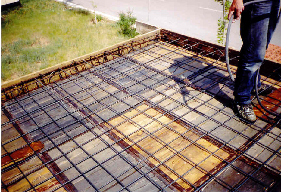
Resim 2.2. Deney yapısının döşeme demirleri
