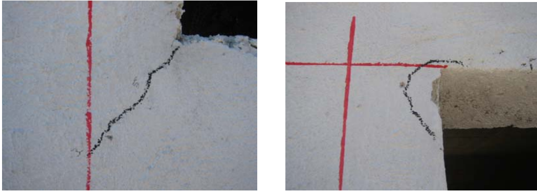
Resim 3.1. Deney Yapısı-1'in 5. yükleme sonunda görünüşü
