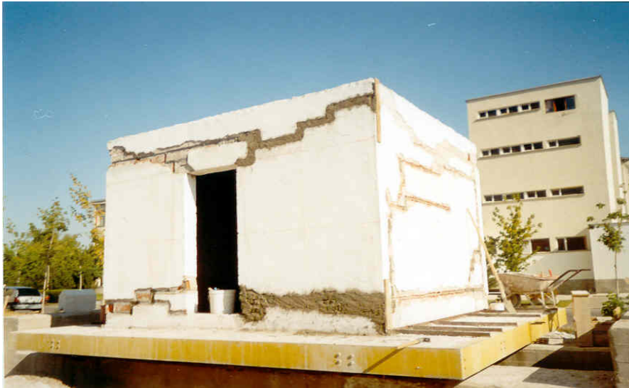
Resim 2.5. Deney yapısının onarılması (güney cephe)
