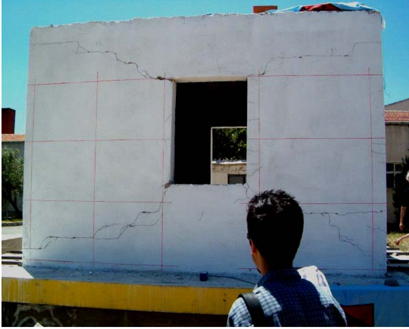
Resim 3.9. Deney Yapısı-1 kuzey cephenin 13. yükleme sonunda görünüşü
