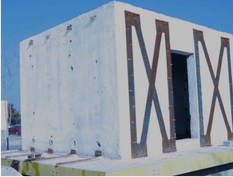
Resim 3.26. Deney Yapısı-3 güney ve batı cephenin 18. yükleme sonunda görünüşü
