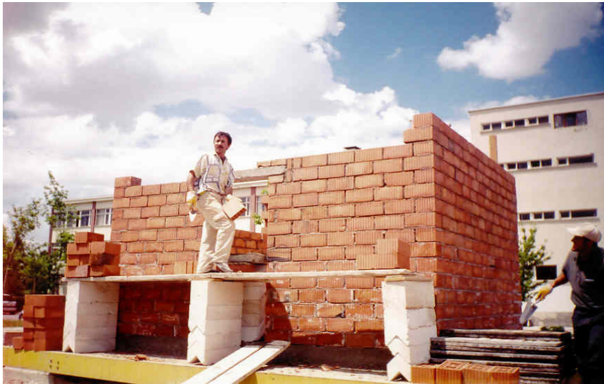
Resim 2.1. Deney yapısının duvarlarının örülmesi
