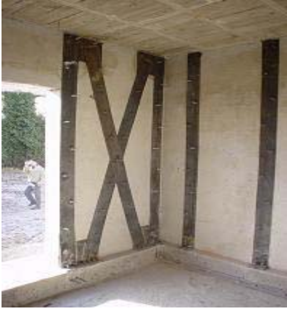
Resim 2.7. Deney Yapısı-2'nin iç duvarlarının görünüşü
