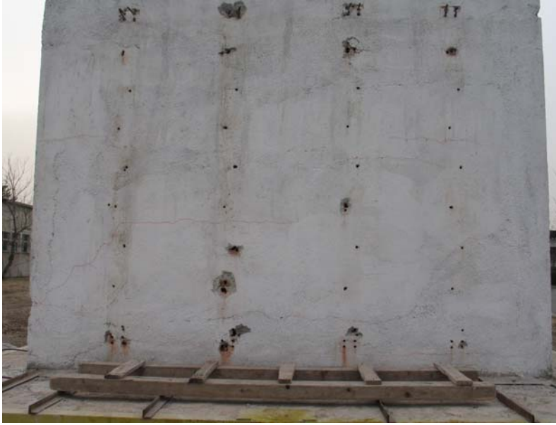
Resim 3.40. Deney Yapısı-5 doğu cephenin 20. yükleme sonunda görünüşü
