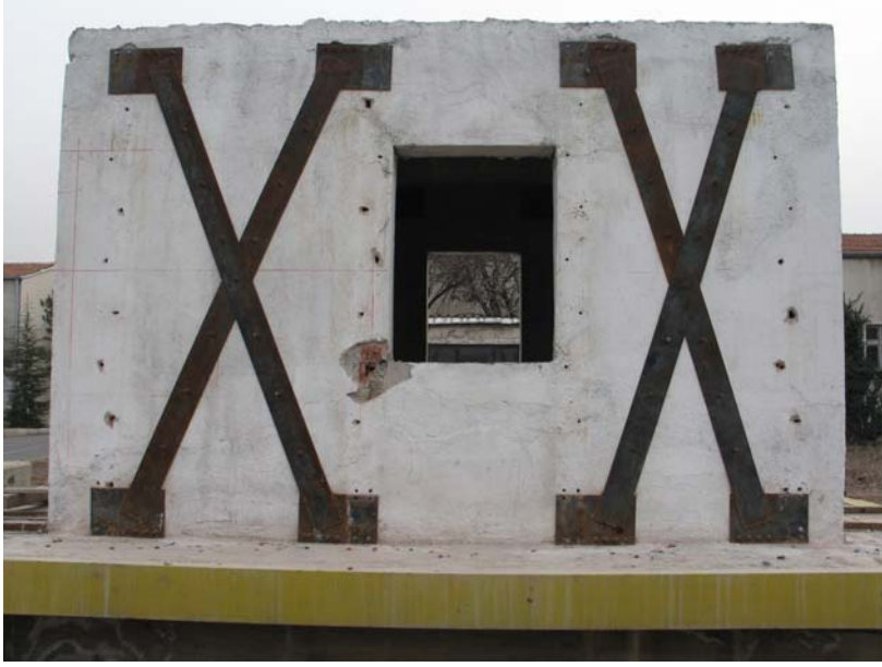
Resim 3.34. Deney Yapısı-5 kuzey cephenin 20. yükleme sonunda görünüşü
