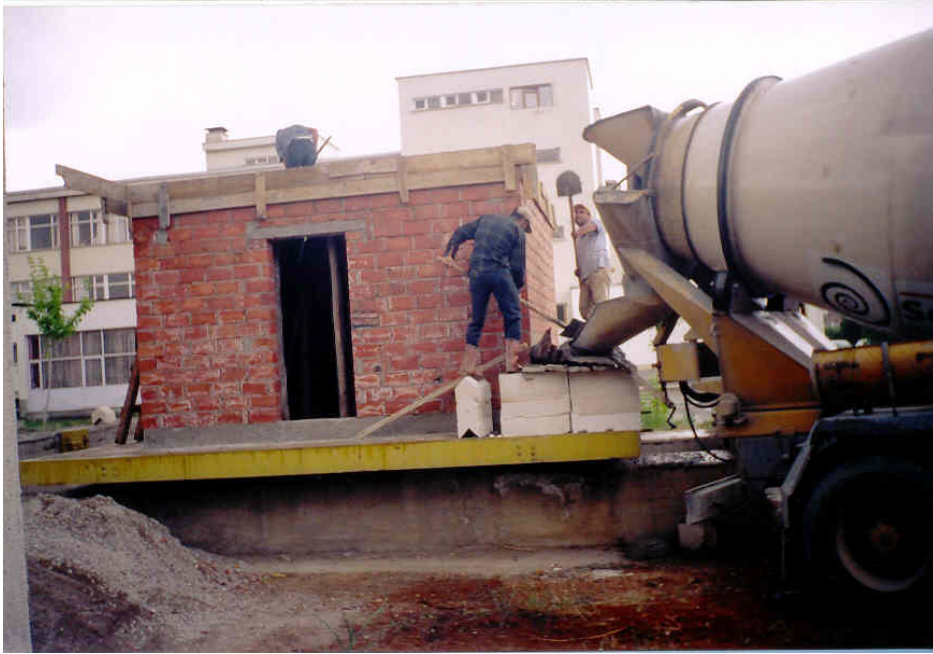
Resim 2.3. Deney yapısının üst hatıl ve döşeme betonunun dökümü
