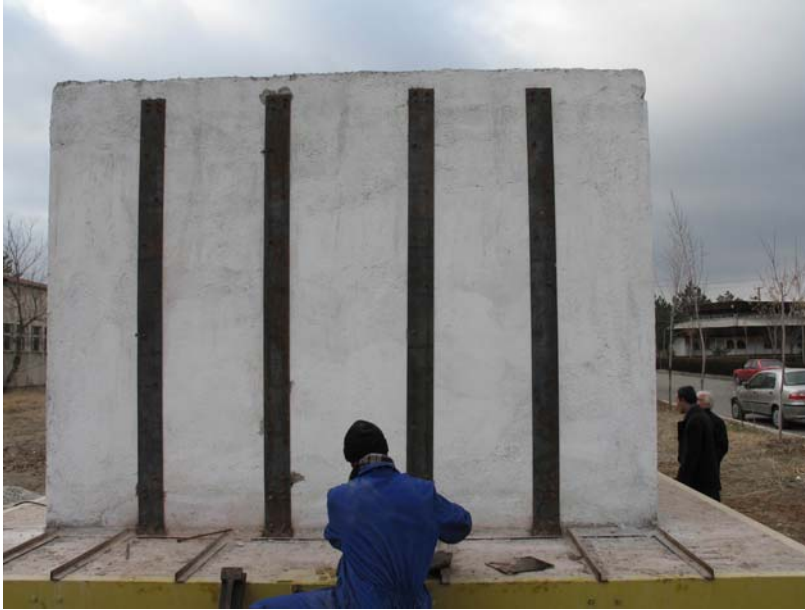
Resim 3.23. Deney Yapısı-2 doğu cephenin 18. yükleme sonunda görünüşü
