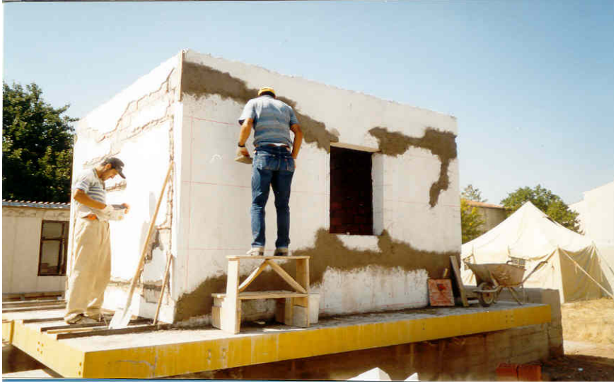
Resim 2.4. Deney yapısının onarılması (kuzey cephe)
