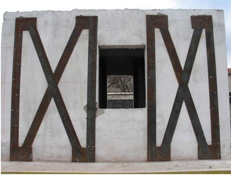
Resim 3.22. Deney Yapısı-2 kuzey cephenin 18. yükleme sonunda görünüşü
