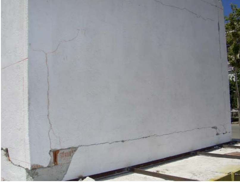
Resim 3.17. Deney Yapısı-1 batı cephenin 16. yükleme sonunda görünüşü
