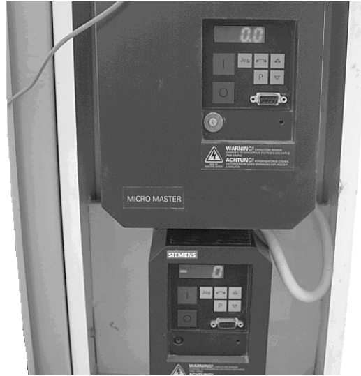
Şekil 4.2. Vagonun ve Testerenin Hızını Kontrol Eden Hız İnvertörleri.
