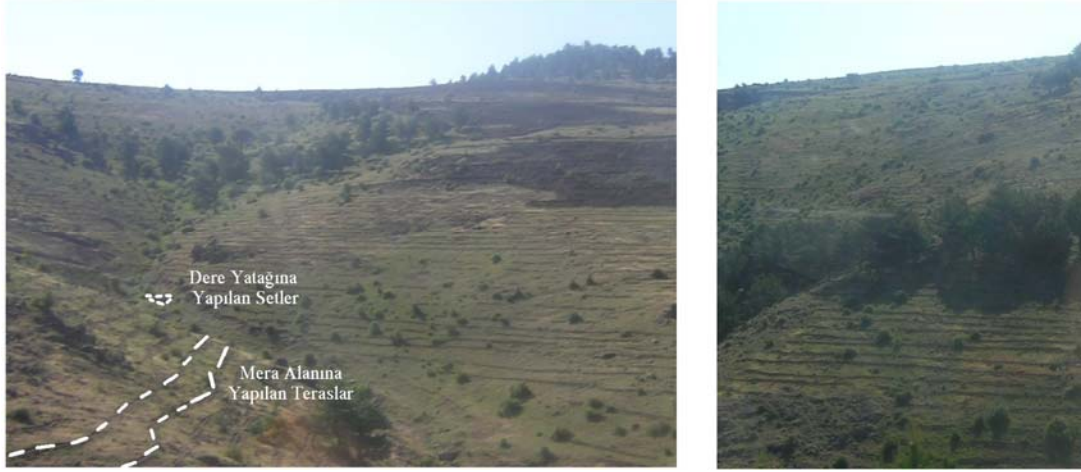
Foto : 26, 27 – Havzadaki meralarda yapılan teraslar ve bentler
