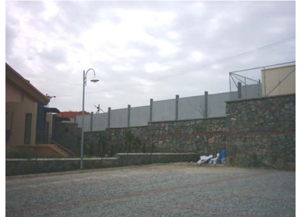
Şekil 5.26 Aqua Manors çevre duvarları
