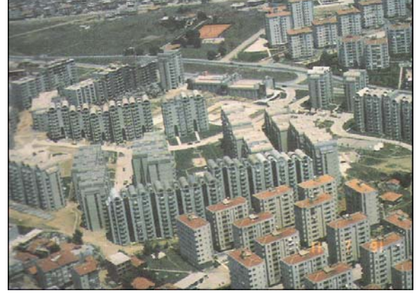
Şekil 3.5 İstanbul Soyak Göztepe yerleşmesi
