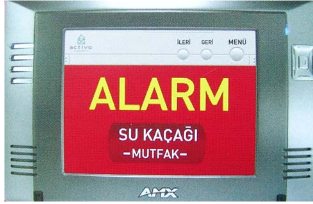
Resim 3.30: Su kaçağını ve mekanı gösteren touch panel
