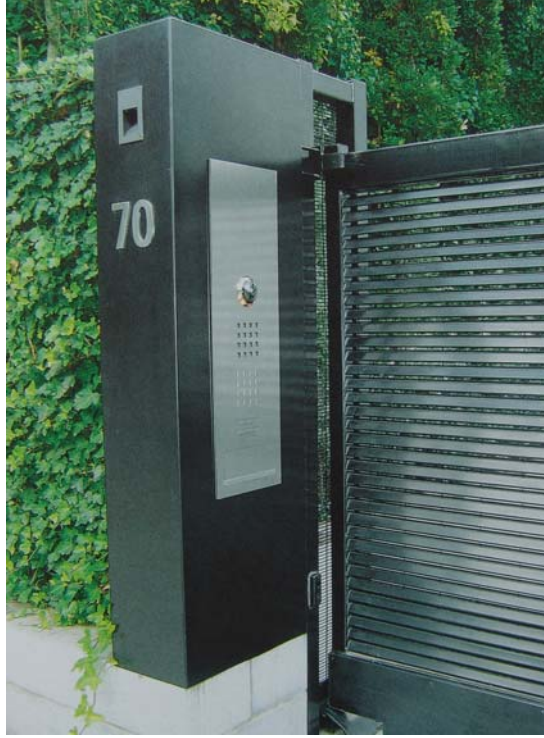
Resim 3.38: Kapı girişinde kameralı görüşme sistemi.
