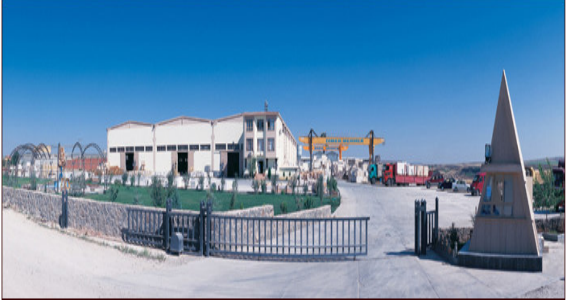
Şekil 3.1. Dimer Mermer İşleme Fabrikası'nın Dış Görünümü
