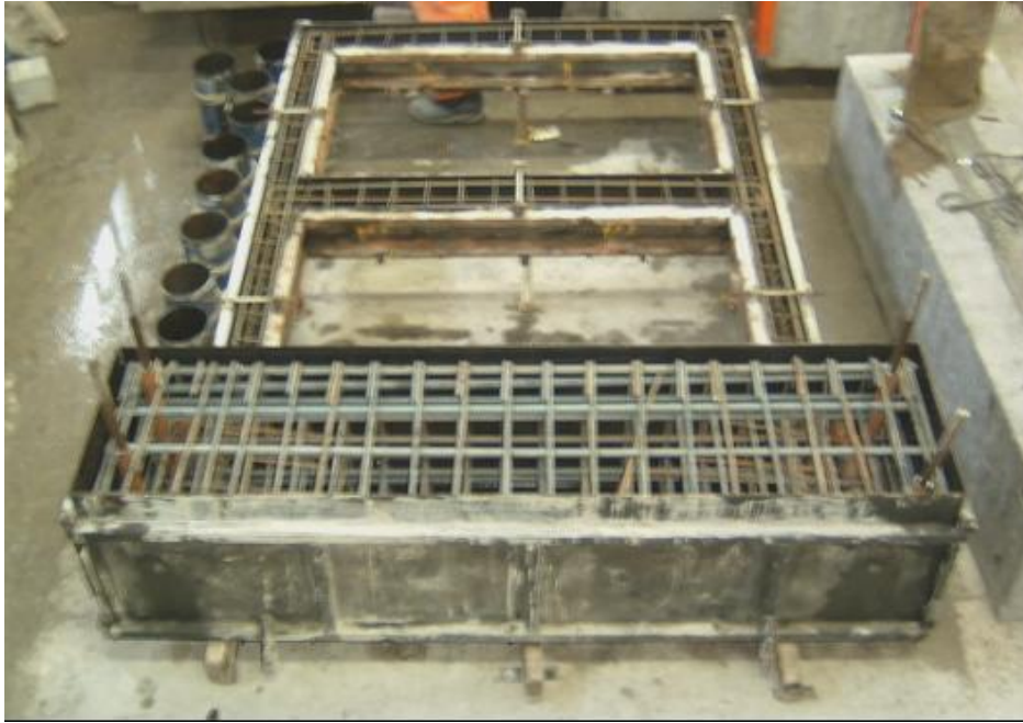
Resim 2.2. Kalıp iine yerleřtirilmiř çerçeve donatısı
