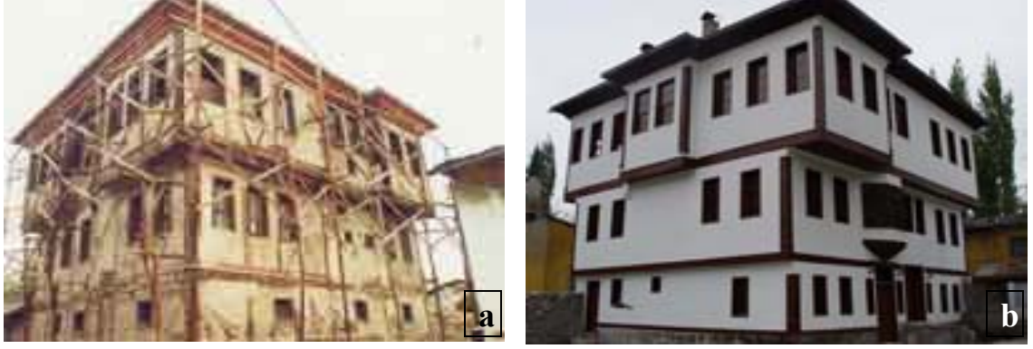
Şekil 4.75 Sivas, Akaylar Konağı restorasyon öncesi ve sonrası
