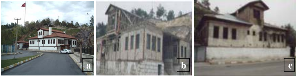
Şekil 5.18 Sivas, Osman Ağa Konağı restorasyon sonrası ve öncesi
