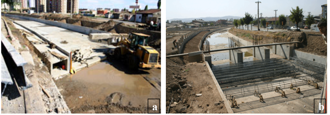
Şekil 5.6 Sivas, AK-SU dere ıslah projesi birinci etap çalışmaları
