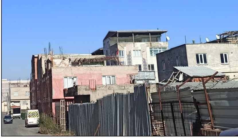
Şekil 38. Mevlana Mahallesinde Kaçak Yapılara Örnek
