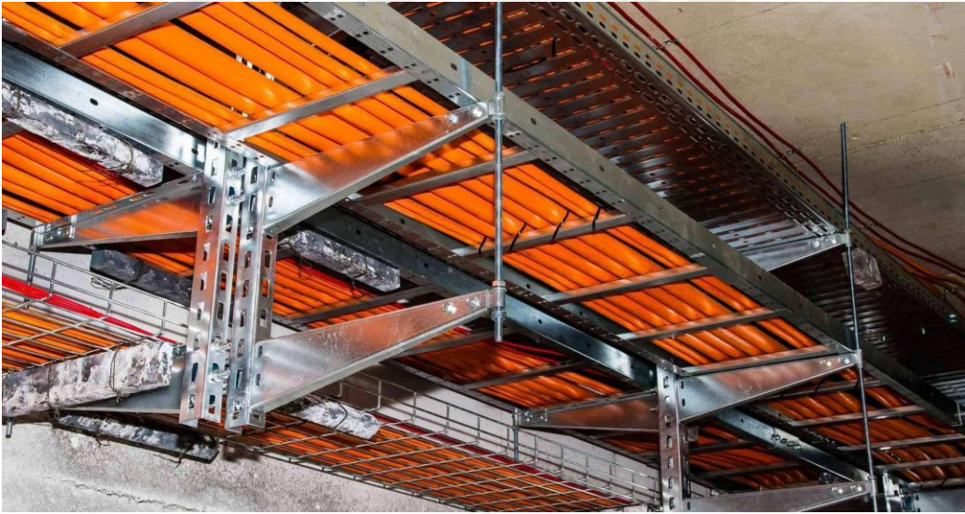
Şekil 3.9 Tavaya döşenmiş DC kablolar [4]
