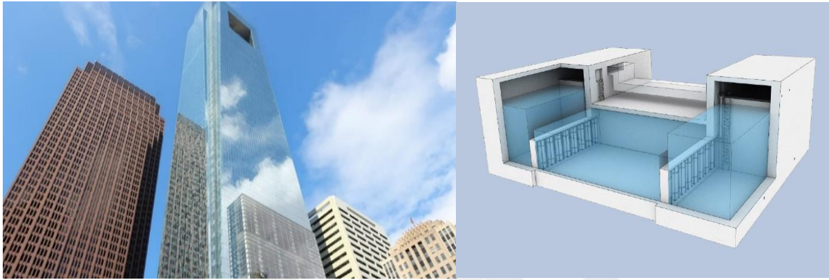
Şekil 2.13: a) Comcast Center binası, b) Yapıda kullanılan TLCD şekli (motioneering.ca).
