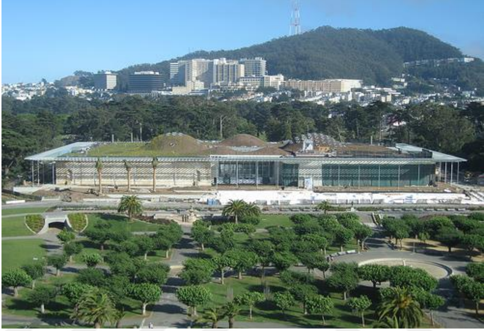
Şekil 18. San Francisco'daki yeni Kaliforniya Bilimler Akademisi binası, 2005 Kaynak: Url-5
