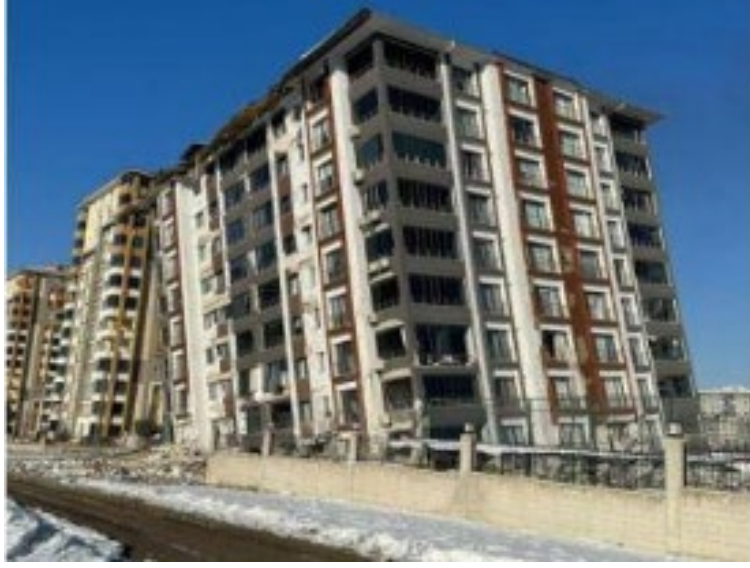
2.10. Kahramanmaraş Depremi, Malatya 2023
