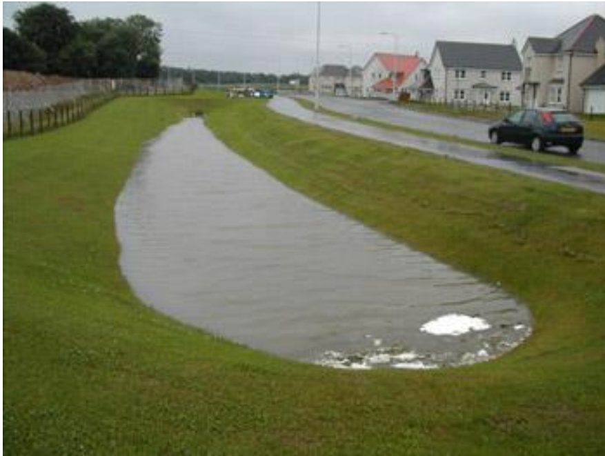
Resim 3.4. Bekletme Havuzu (dolu) ( www.sudswales.com )
