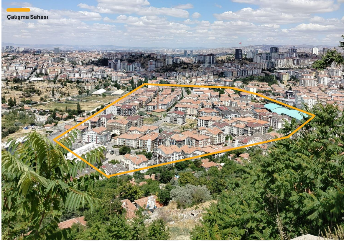
Resim 5.3. Çalışma sahası-çarpık kentleşme
