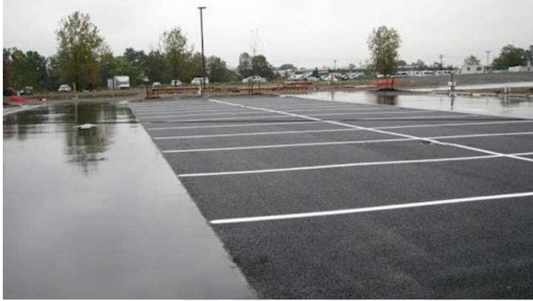
Resim 3.15. Geçirgen Asfalt ( www.sogukasfalt.com )
