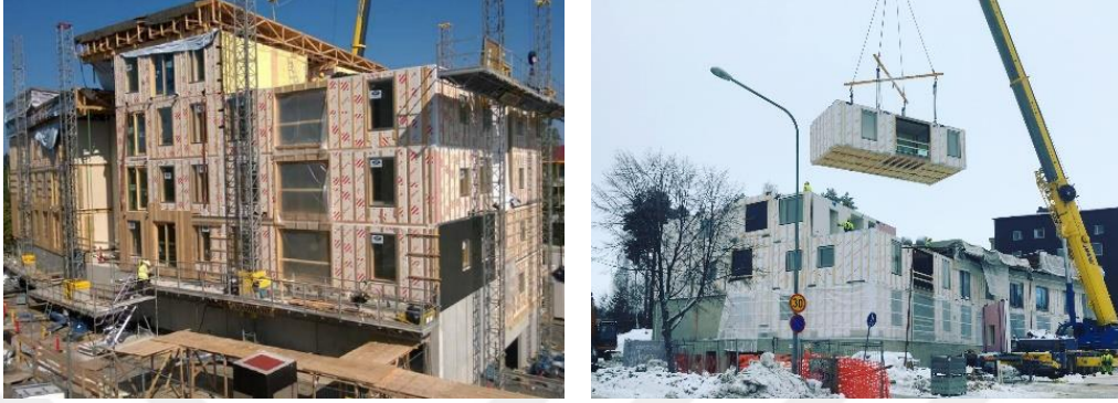
Şekil 3.5 Puukuokka binasının montajı [153], [155]
