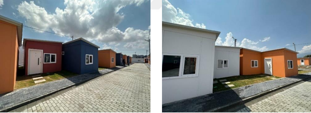
Şekil 2.2 İBB Hatay Geçici Yaşam Merkezi geçici konutları [39]
