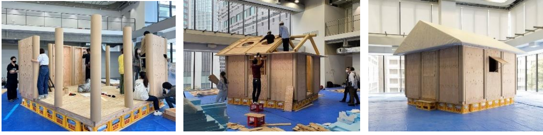
Şekil 2.29 Kâğıt tüp geçici konutun prototip üretim aşaması [67]
