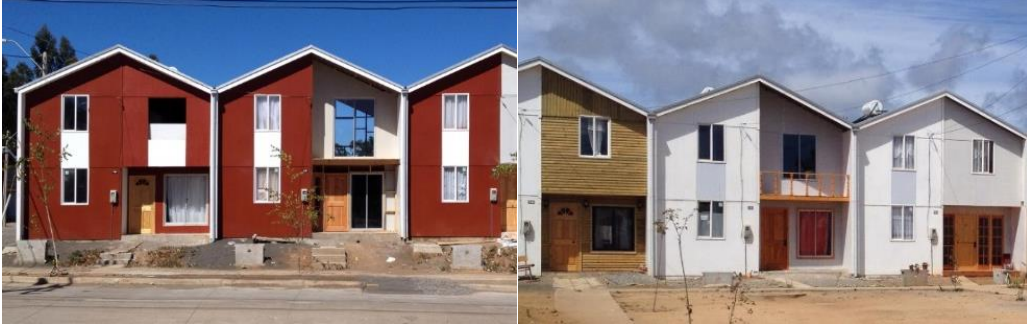
Şekil 2.42 Şili’de inşa edilen Villa Verde Konutlarının kullanıcılar tarafından yapılan farklı uygulamalar [127]
