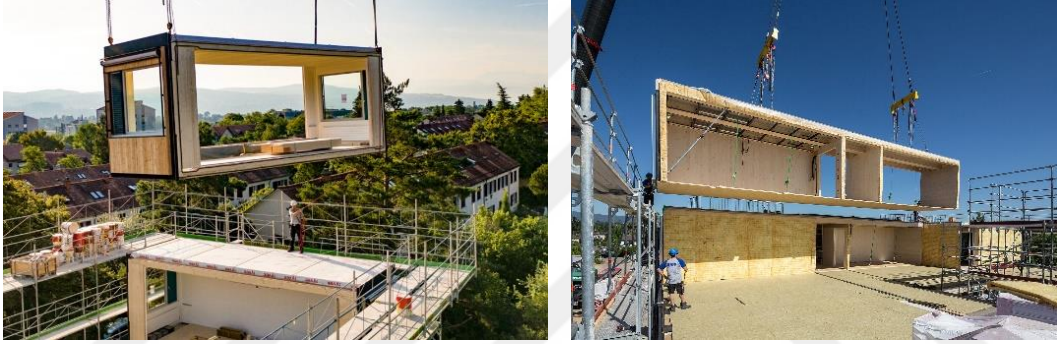
Şekil 3.14 Açık modülerin montajı [181], [182]
