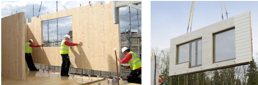
Şekil 3.9 Panel modüler sistem (2D Sistem) [169], [170]
