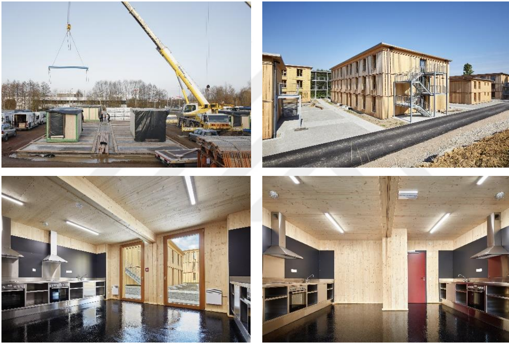
Şekil 3.26 Freiburg’da mülteci geçici konutların montajı ve mekânları [194]
