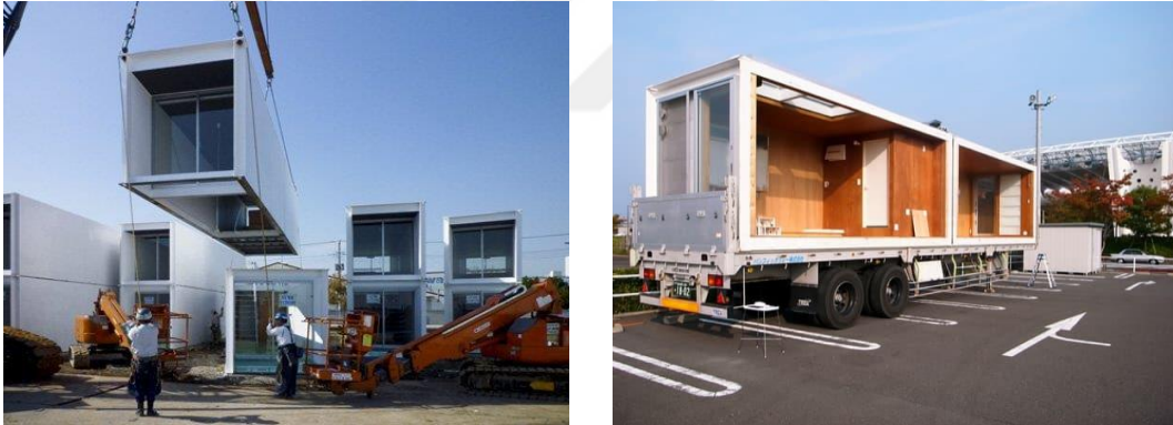
Şekil 2.4 Ex-Container taşıma ve montajı [40], [41]
