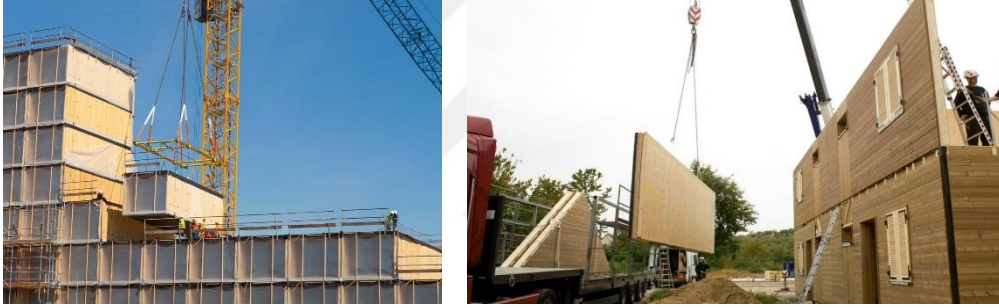
Şekil 3.17 Hücre ve panel modüler yapısal elemanlarının montaj aşamaları [172], [187]
