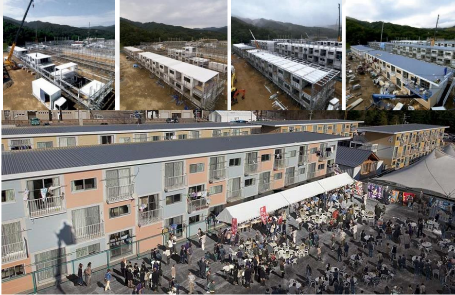
Şekil 2.12 Onagawa konteyner geçici konut üretimi [45], [46]
