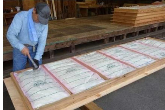
Şekil 2.20 Kumamoto Geçici Konutunun inşa sahasındaki montaj aşaması ve panel üretimi [53], [54]
