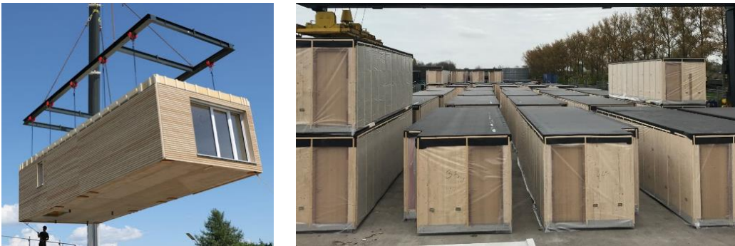
Şekil 3.10 Hücre modüler sistem (3D Sistem) [171], [172]
