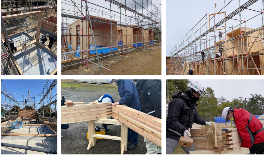
Şekil 3.21 Suzu Mitsukejima'da DLT Geçici Konutu inşaatı [188], [190]
