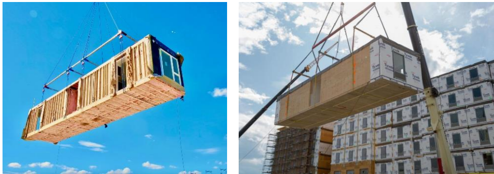
Şekil 3.15 Kapalı modülerin montajı [183], [184]
