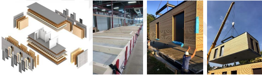
Şekil 3.24 Aktivhaus Geçici Konut modüllerin üretim ve montaj aşamaları [193]
