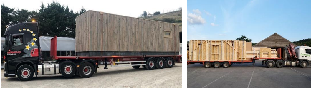
Şekil 3.16 Hücre ve panel modüler yapısal elemanlarının nakliyesi [185], [186]
