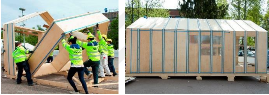
Şekil 2.18 Liina geçici konutu montaj aşamaları [51], [52]
