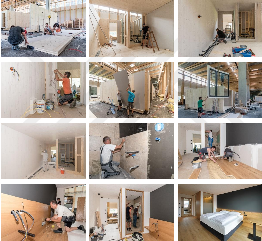
Şekil 3.8 Ahşap modüler birimin üretimi [164], [165]
