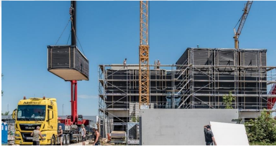
Şekil 3.18 Hücre modüllerin montaj aşaması [165]
