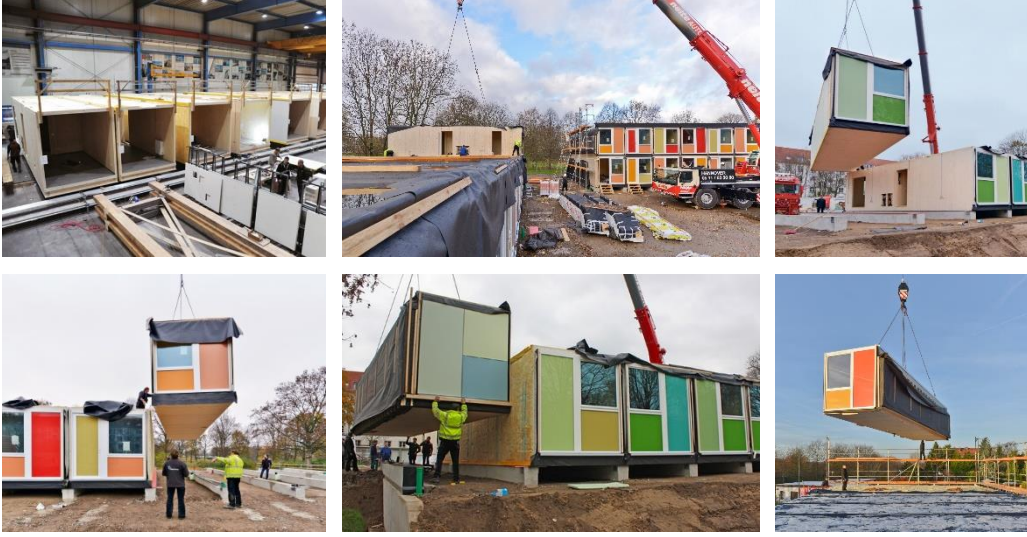
Şekil 3.29 Hannover’de mülteci geçici konut projesinin üretimi ve montaj aşamaları [196], [198]
