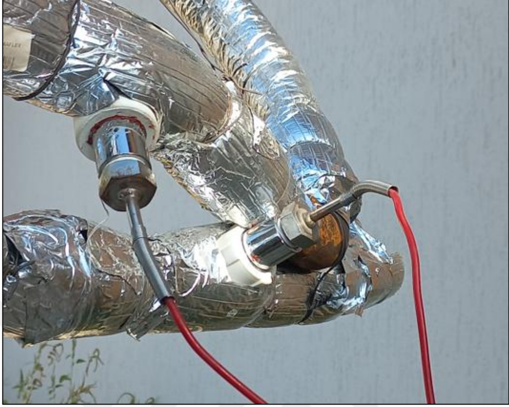
Şekil 3.40. Akışkan sıcaklık ölçüm termokupları
