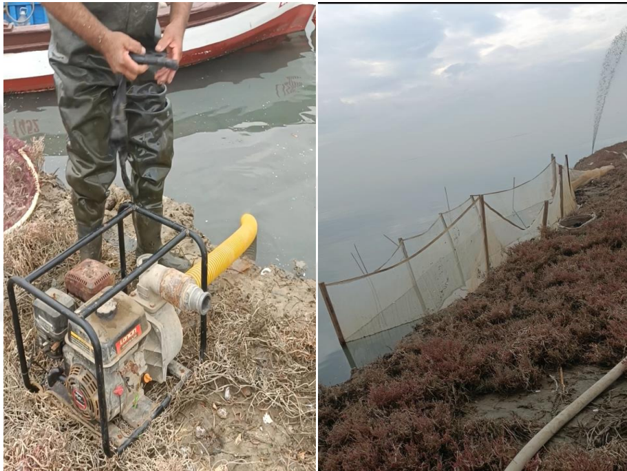
Şekil 3-16 Çamuru karıştırmak için kullanılan motor ve sağ tarafta yarattığı tazyik
